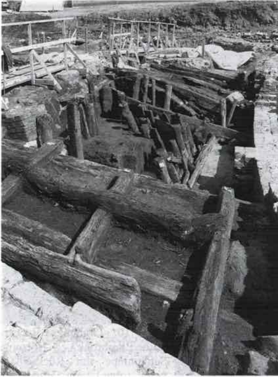
Abb. 11: Grabung „Beckergrube/Ellerbrook“. Über einer Kloake verlegter Holzrost als Substruktion für das steinerne Quergebäude im Hof (Fischergrube 59).
