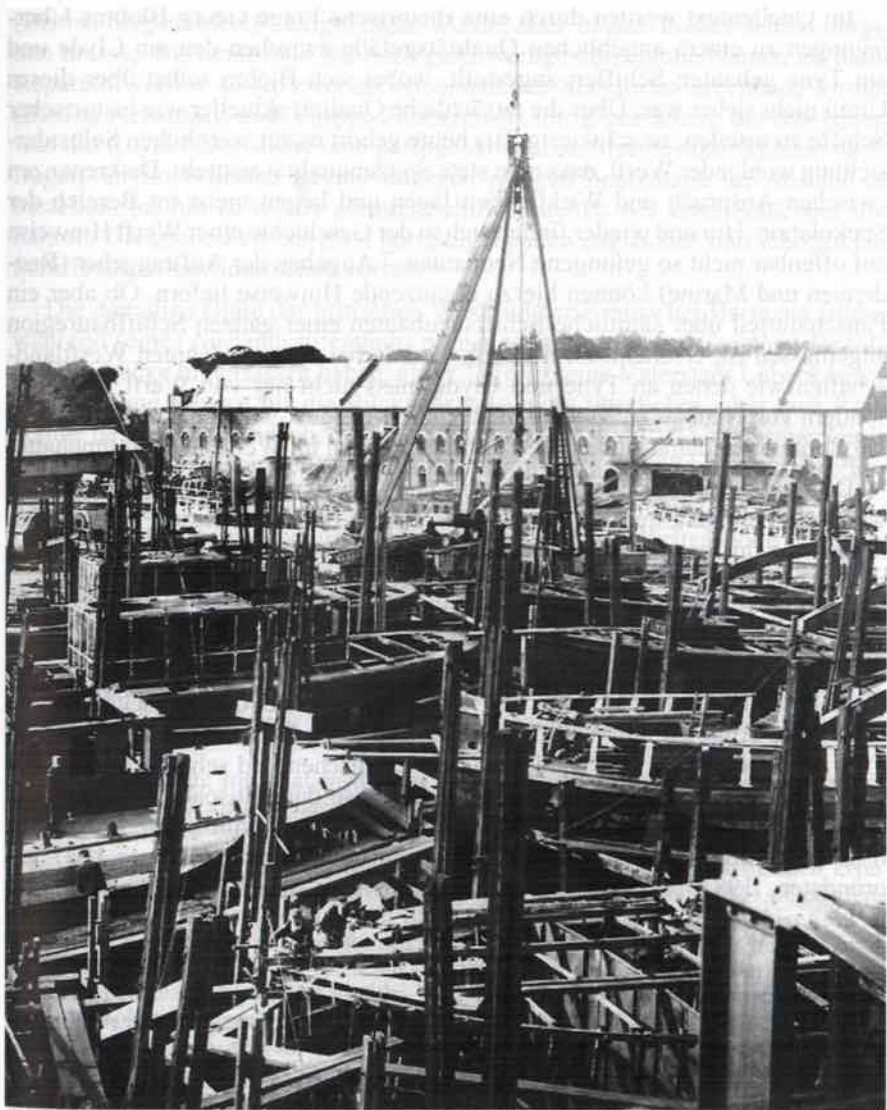
Abb. 7: Lobnitz, Coulborn & Co. Ltd. in Renfrew um 1888. Im Hintergrund das Hauptgebäude der Werft sowie einen zeitüblichen Dreibeinkran von schätzungsweise 60-80 Tonnen Hebefähigkeit, der zur Installation schwerer Ausrüstungsteile wie Kessel und Maschinen diente. Die zahlreichen im Bau befindlichen Neubauten im Vordergrund zeigen nicht nur die Intensität der Produktion an, sondern auch die Spezialisierung der Firma auf kleinere und mittlere Schiffseinheiten (Glasgow University Archive System).
