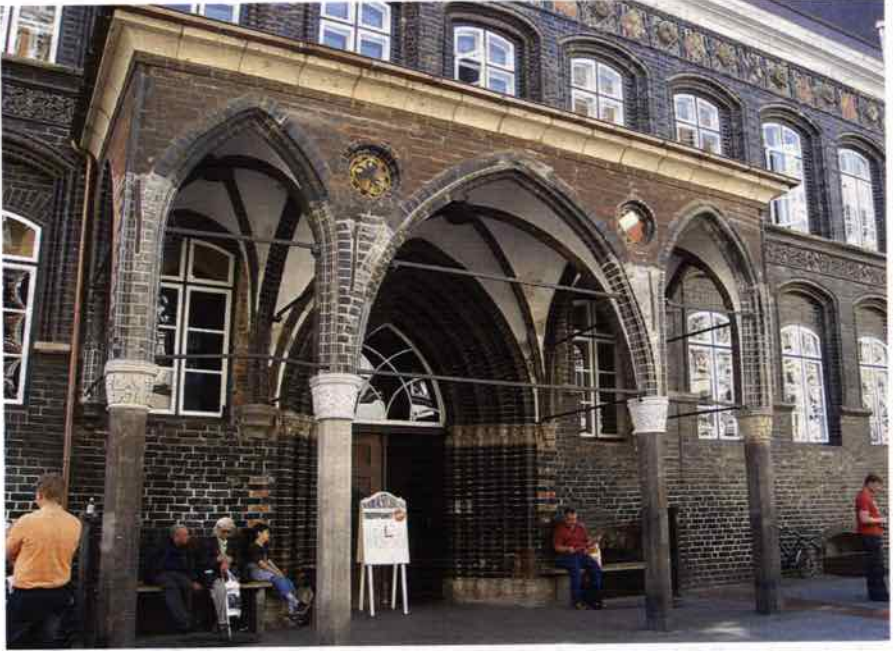
Abb. 9: Rathaus, Vorhalle am Haupteingang, Zustand nach statischer Sicherung und Erneuerung der Kapitelle
