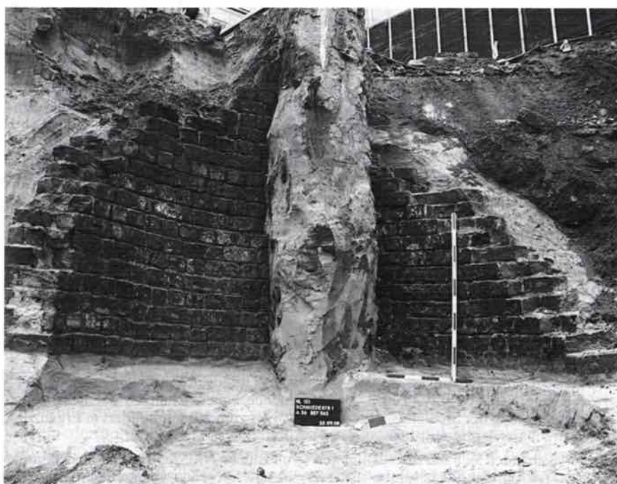
Abb. 7: Schmiedestraße 1-15: Moderner Bohrpfahl inmitten eines mittelalterlichen Abfallschachtes.
