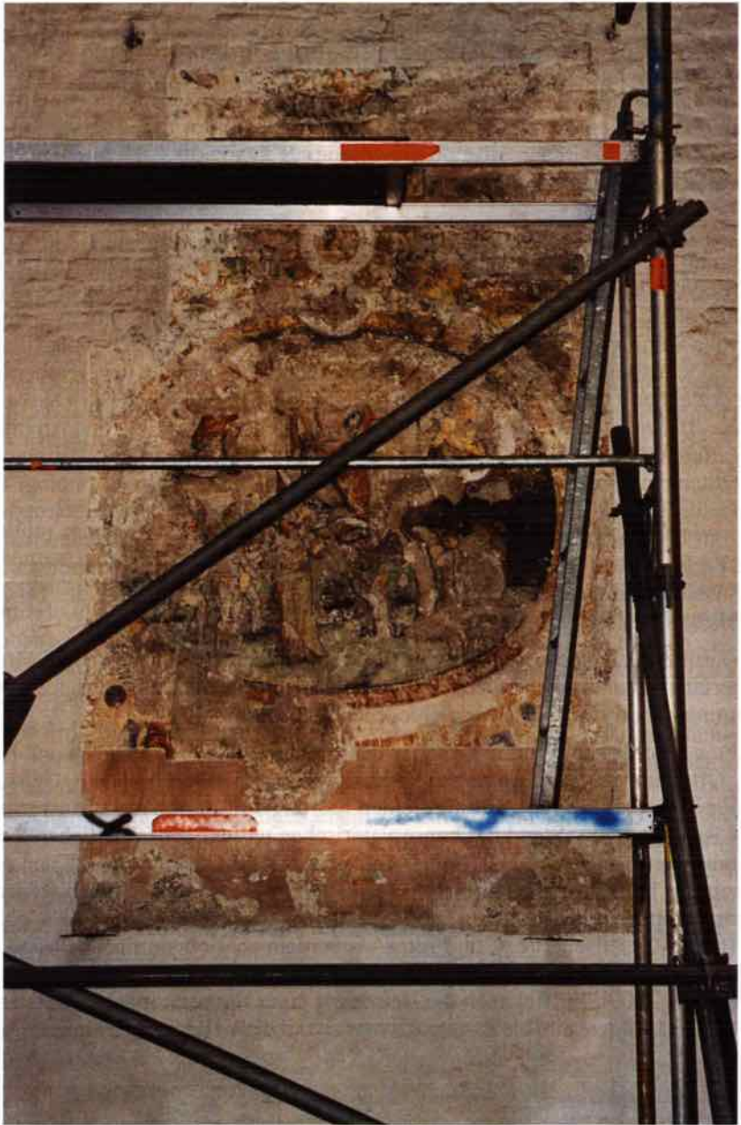
Abb. 1: St. Aegidienkirche, Woltersenkapelle, Wandmalerei während der Restaurierung
