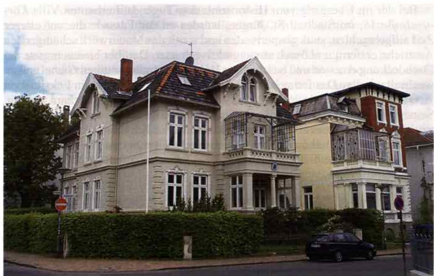
Abb. 17: Körnerstr. 18, Gesamtansicht vor der Sanierung
