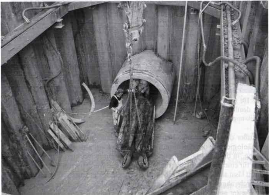
Abb. 18: Parkstraße / Krügerstraße. Förderung der „Holzhindernisse“ aus dem Press- schacht.
