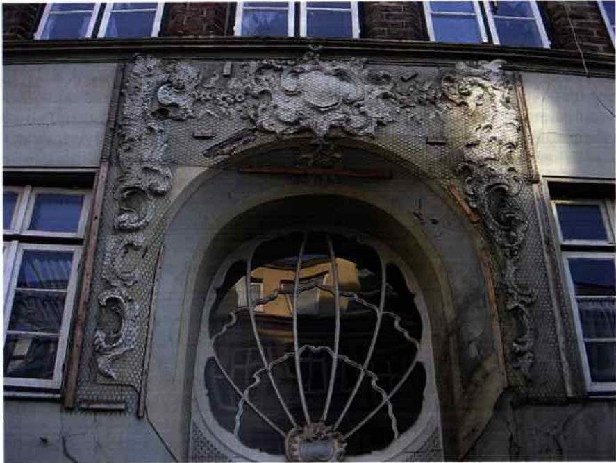
Abb. 9: Große Altfähre 33, vor der Sanierung
