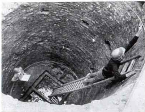
Abb. 5: Schüsselbuden 16. Kloakenschacht während der Freilegung in den 1950er Jahren (Mittelalter).
