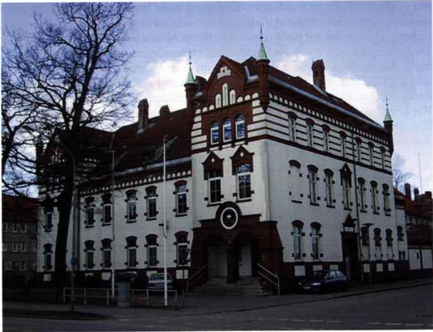
Abb. 12: Meesenring 1 (vor der Sanierung)
