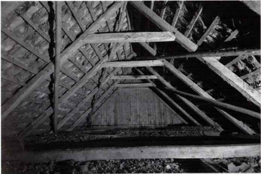
Abb. 6: Dachraum nach Norden, im Hintergrund die nachträgliche Seilverspannung am Gespärre V.
