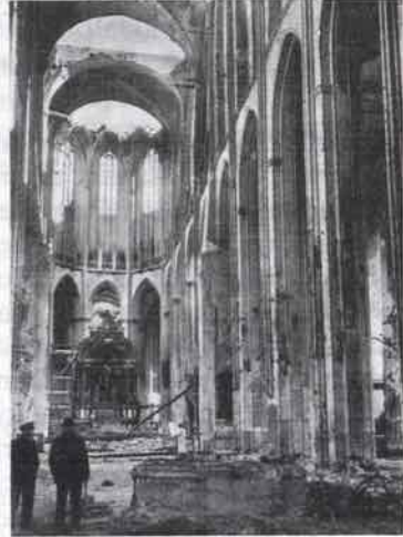
Blick zum Chor nach der Zerstörung
