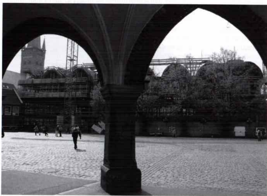
Abb. 15: Neubau des Geschäftshauses Peek & Cloppenburg (P&C)
