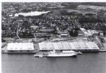
Abb. 6: Terminal Skandinavienkai mit Containerterminal
