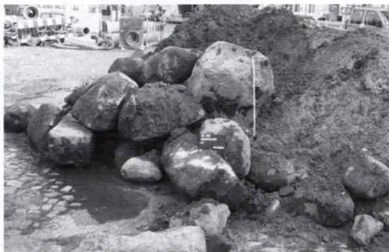
Abb. 14: Obertrave/Depenau. Aus dem Untergrund der Straße stammende mächtige Findlinge, die vermutlich zur Befestigung und Erhöhung des ursprünglich sumpfigen Geländes hier eingebracht worden sind.
