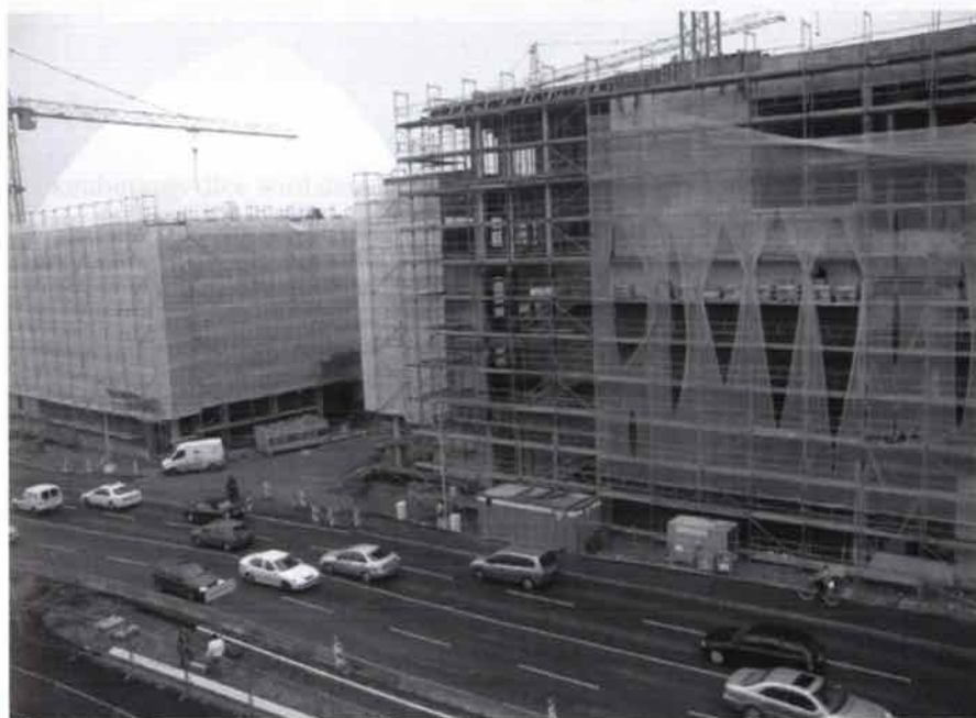
Abb. 14: LindenArcaden im Bau, Blick von der Fackenburg Allee aus
