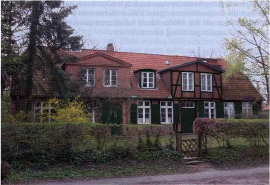
Abb. 11: Waldstraße 31, Israelsdorf, ehemalige Dorfschule, Ostfassade nach der Sanierung
