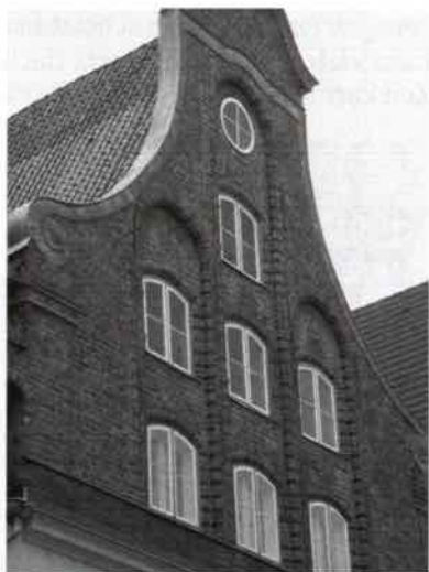
Abb. 10: Beckergrube 89. Die Hochblendarchitektur des 15. Jahrhunderts wurde dem barocken Glockengiebel neu angepaßt.
