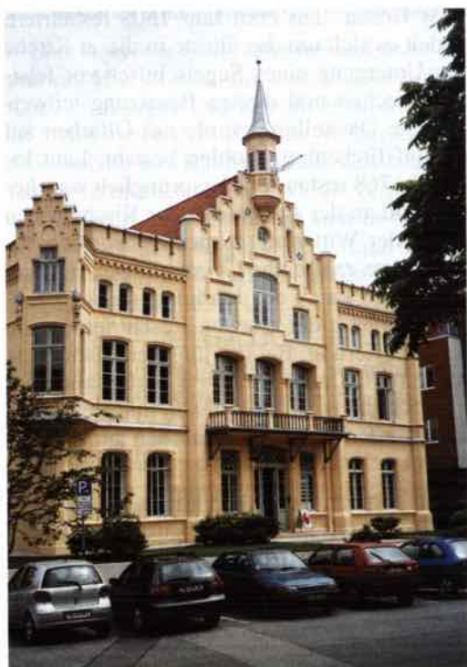
Abb. 10: Parade 1 nach der Sanierung.
