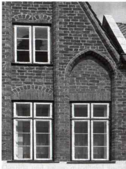
Abb. 13: Das Vorderhaus des Ihlhornstiftes Glockengießerstraße 39. In den spätmittelalterlichen Hochblendgiebel von 1476/77 wurde um die Mitte des 19. Jahrhunderts eine Beletage eingebaut und dazu die Hochblenden um acht Steinlagen nach unten verlängert.
