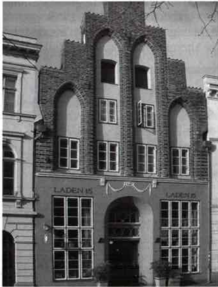
Abb. 4: Königstraße 30. Der Giebel aus der Zeit um 1300 zwischen älteren Brandmauern der Nachbarhäuser. Die Firstzinne und die seitlichen Staffeln wurden im 16. Jahrhundert nachträglich aufgesetzt.
