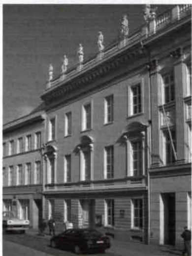
Abb. 11: Das Behnhaus, Königstraße 11. Die Fassade 1789 vor zwei mittelalterlichen Häusern neu erbaut.
