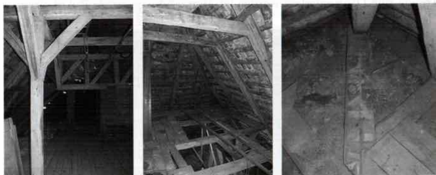
Abb. 32-34: Details des Dachgeschosses, Abb. 34 zeigt das Unterlagebrett eines Gratsparrens, das vermutlich im Vorgängerbau Teil einer Deckenbemalung des späten 18. Jahrhunderts gewesen ist (siehe Detail in Abb. 38).
