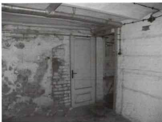
Abb. 16: Südliche Wand des straßenseitigen Kellerraums mit vermauertem Durchgang zum ehemals anschließenden Keller teil (Januar 2004).
