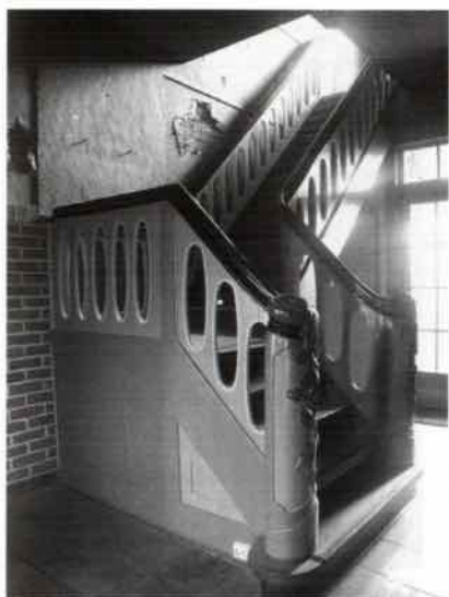
Abb. 35: Treppe zum Obergeschoss in der Diele des Erdgeschosses.
