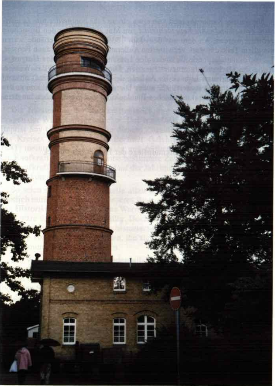
Abb. 17: Alter Leuchtturm Travemünde, Am Leuchtenfeld 1.
