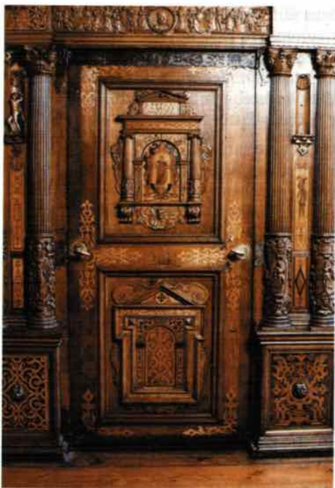
Abb. 14: Doppelt angeschlagene Tür S3H
