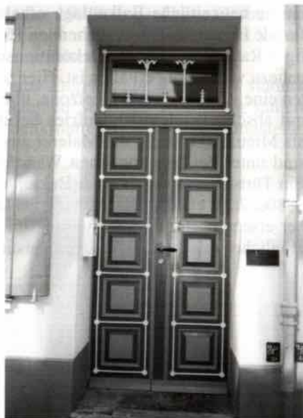
Abb. 7: Blocksquerstr. 16, Nachbau der klassizistischen Haustür
