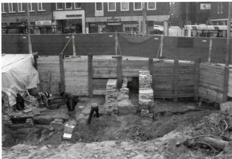
Abb. 4: „Postgrabung“. Die Mauerzüge in der Bildmitte säumten den einst hier verlaufenden Düsteren Krambuden. Links: Der Grundriß eines Holzkellers wird freigelegt.
