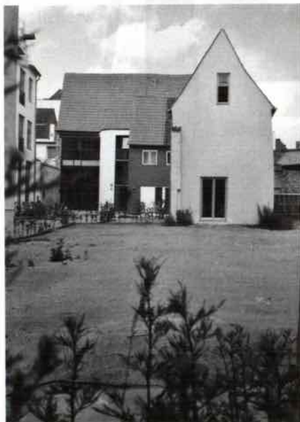
Abb. 10: Fischergrube 82, Seitenflügel und Querhaus nach der Sanierung
