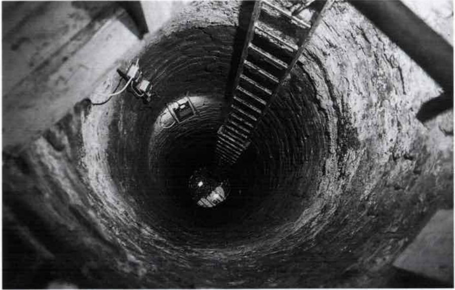
Abb. 9: Grabung „Markt“. 9 Meter tiefer Backstein-Brunnen aus dem Mittelalter an der Ecke Marktwiese/Markt.
