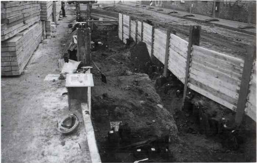
Abb. 6: Fleischhauerstraße, Gründungsmaßnahme für die Küterhäuser ?
