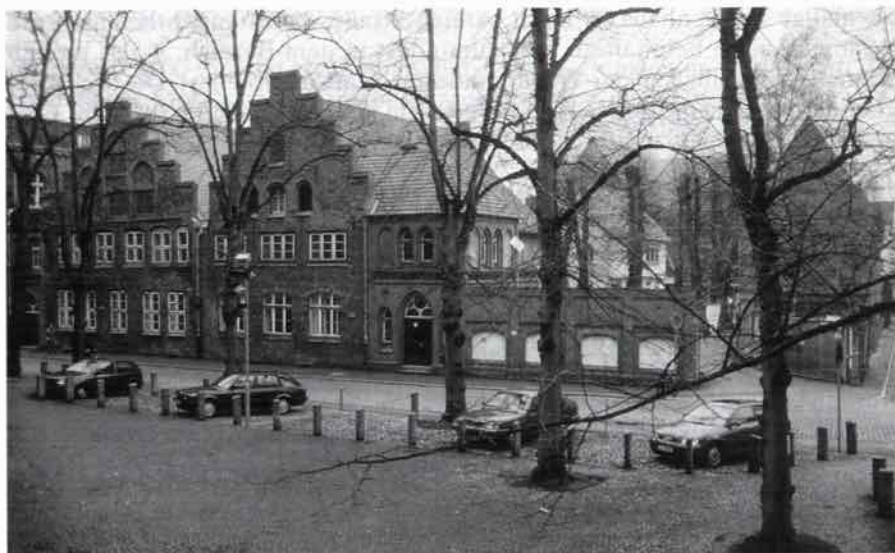
Abb. 2: Aegidienhof, mittelalterliche Konventgebäude an der St. Annen-Straße 1-5; rechts im Hintergrund der Flügelbau an der Weberstraße.
