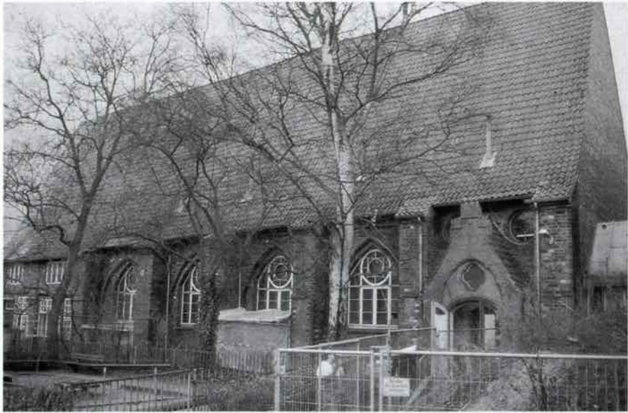
Abb. 6: Im Beichthaus des ehemaligen Burgklosters (Ansicht von Süden) wird im Jahr 2004 die Dauerausstellung „Archäologie in Lübeck - von der slawischen Burg bis zur mittelalterlichen Großstadt“ ihren Platz finden.
