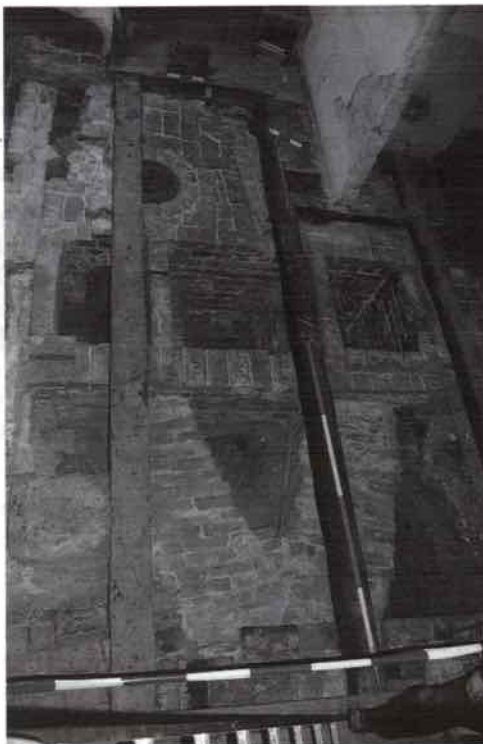
Abb. 5: „Technische Anlage“, gefunden unter dem Fußboden des Gebäudes St. Annen-Straße 5 („Aegidienhof“).
