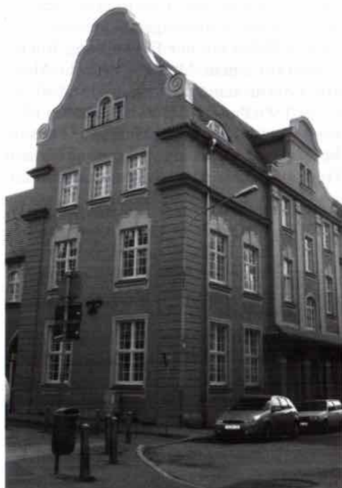
Abb. 7: Bei St. Johannis 5 / Fleischhauerstr. 91, ehemalige Feuerwache
