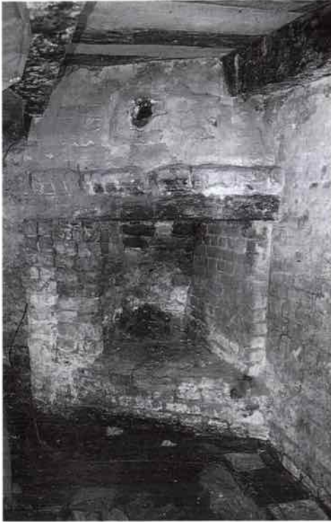
Abb. 5. Der Kamin im Wohnkeller des Hauses Große Altefähre 11.
