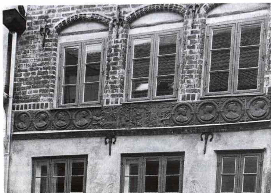
Abb. 7: Depenau 31, Terrakottenband an der Fassade
