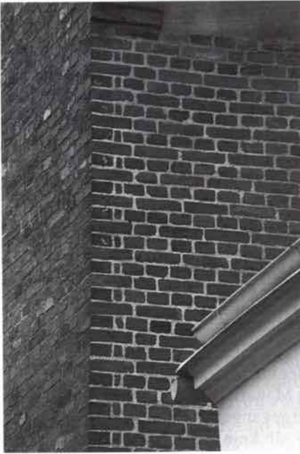
Abb. 4: Wakenitzmauer 118, Mauerwerk der Seitenwand
