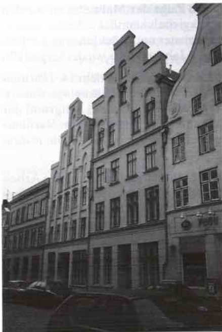
Abb. 8: Straßenansicht der Gebäude Glockengießerstr. 46, 48, 50 nach der Sanierung
