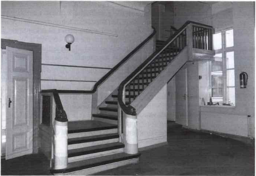
Abb. 10: St. Annen Straße 4, Treppe
