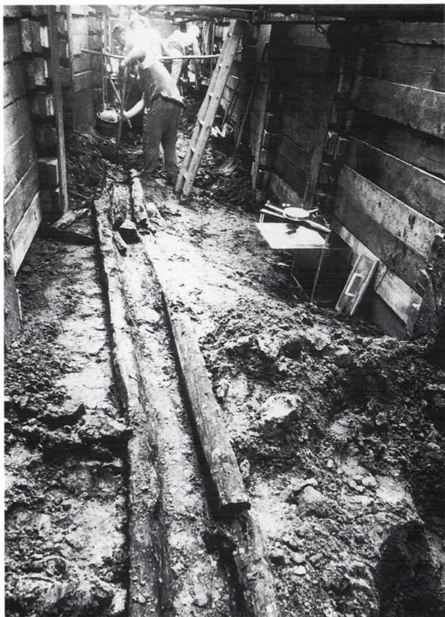
Abb. 2. Hansestadt Lübeck, Königstraße (HL 91). Spätmittelalterliche zweiteilige Rohre der Brauerwasserkunst vorm Hüntertor (Neg.-Nr. A 27561).
