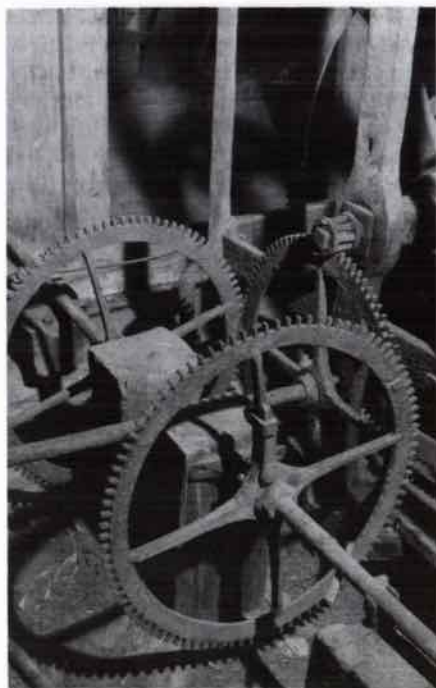
Abb. 13a. Große Uhr. Winkelräderwerk vor der Restaurierung.
