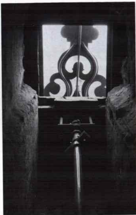
Abb. 15. Große Uhr. Blick hinter das südliche Zifferblatt mit der neuen Zeigerlagerung.
