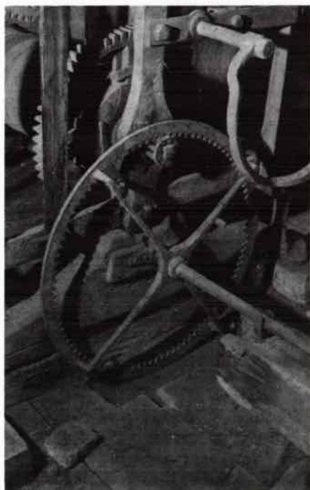
Abb. 18a. Große Uhr. Antrieb der südlichen Zeigerachse vor der Restaurierung.
