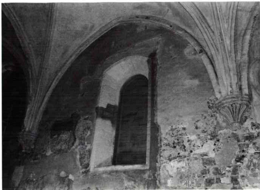
Abb. 3. Ehemaliges Außenfenster in der Südwand des ältesten Nordflügels, heute im nördlichen Kreuzgang. 1988
