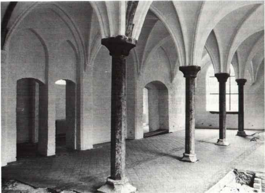
Abb. 23. Halle im Erdgeschoß des Hospitalgebäudes. Im Hintergrund die Durchlässe zum Umgang, vorne links Reste des Schmuckfußbodens, rechts die Öffnung der Heizkammer. Zustand 1989
