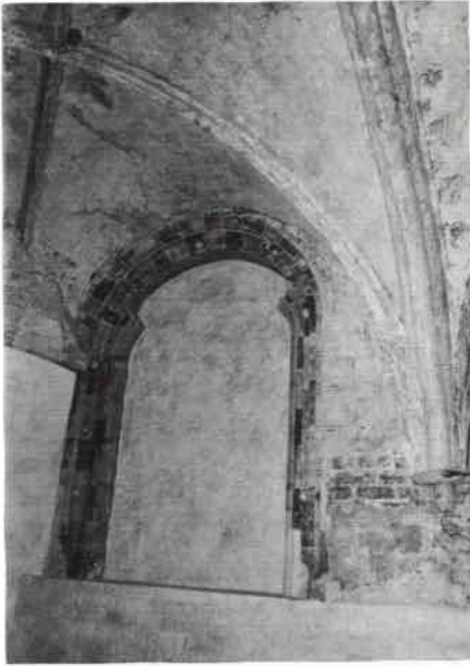
Abb. 5. Freigelegtes ehemaliges Fenster mit alter Bemalung im östlichen Joch des Nordflügels. 1988
