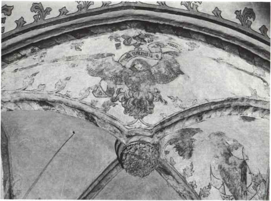
Abb. 12. Freigelegte spätgotische Gewölbemalerei im nördlichen Joch des Kapitelsaales. 1989
