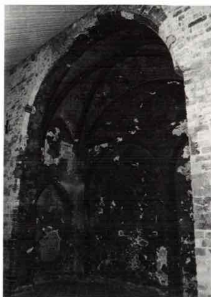
Abb. 2. Östliche Seitenkapelle an der nördlichen Kirchenwand innerhalb des jetzigen Eingangsbaus. 1988
