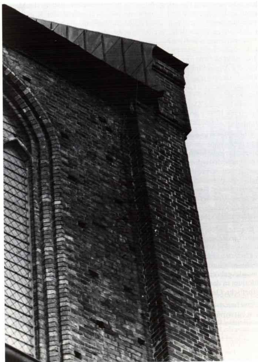
Abb. 2. St. Katharinen, Obergraden West, Fuge zur Westfassade, Detail.
