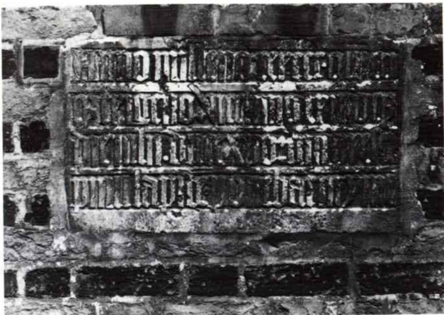
Abb. 1. St. Katharinen, Westfassade, sekundär versetzter Grundstein des Jahres 1355 mit Inschrift sowie umgebendes Mauerwerk.
