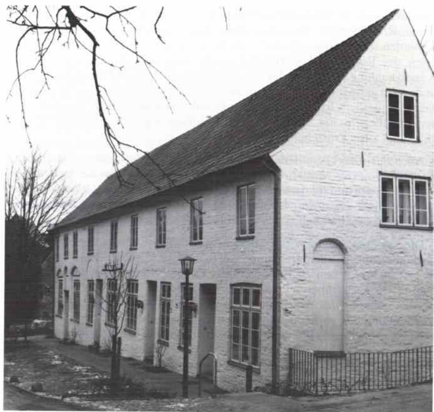
Abb. 18. Kleine Burgstraße 20, sog. Pockenhof, nach dem Umbau
