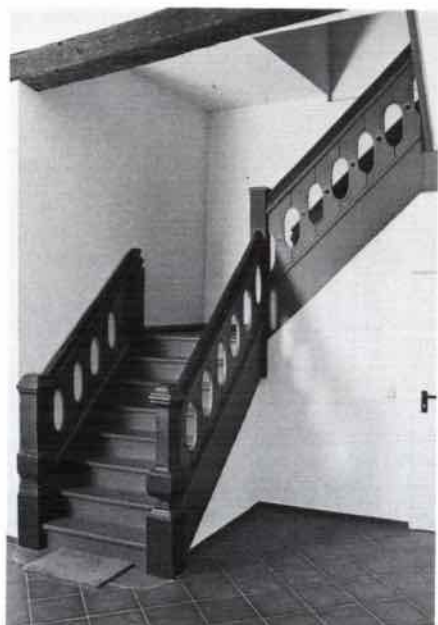
Abb. 31. Fischergrube 20. Dielentreppe nach der Instandsetzung
