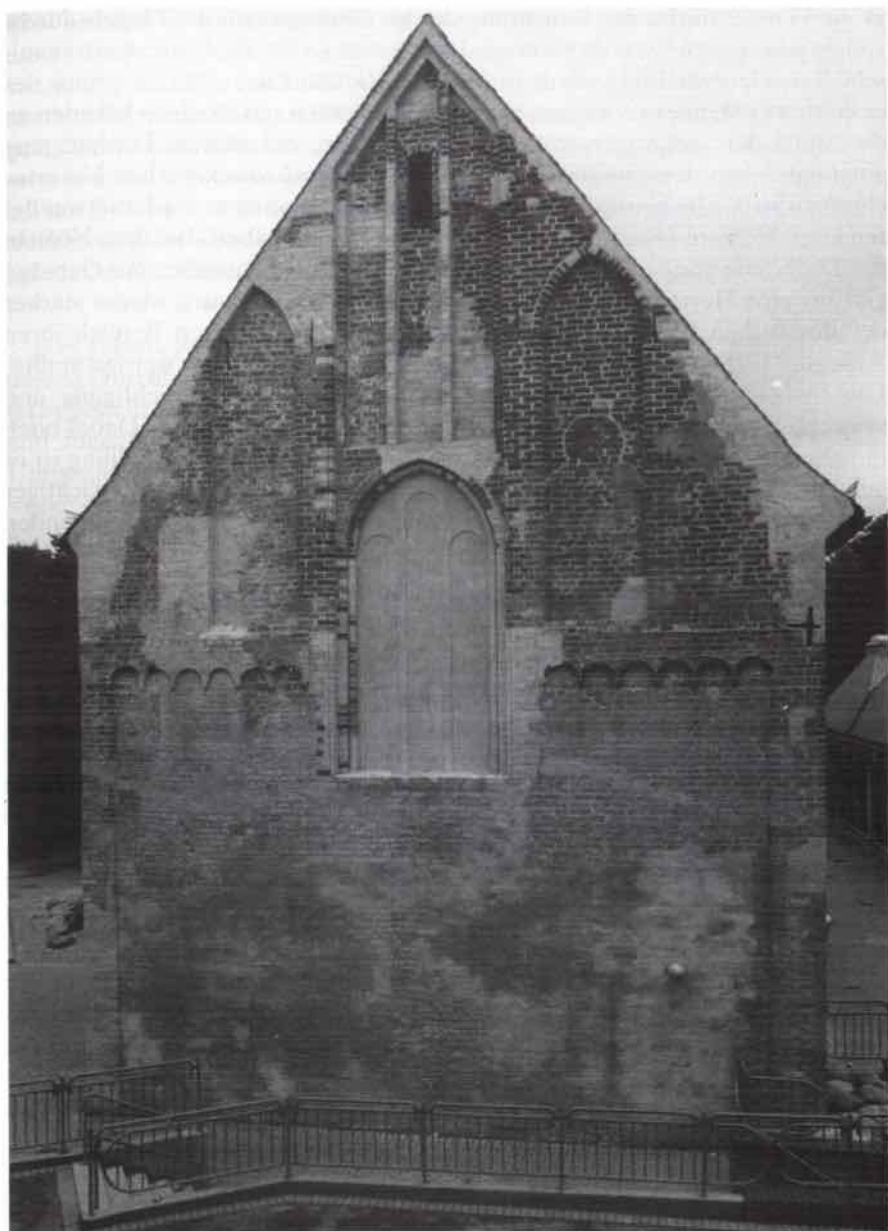
Abb. 9. Refektoriumsbau des ehemaligen Johannisklosters. Westfassade nach der Instandsetzung
