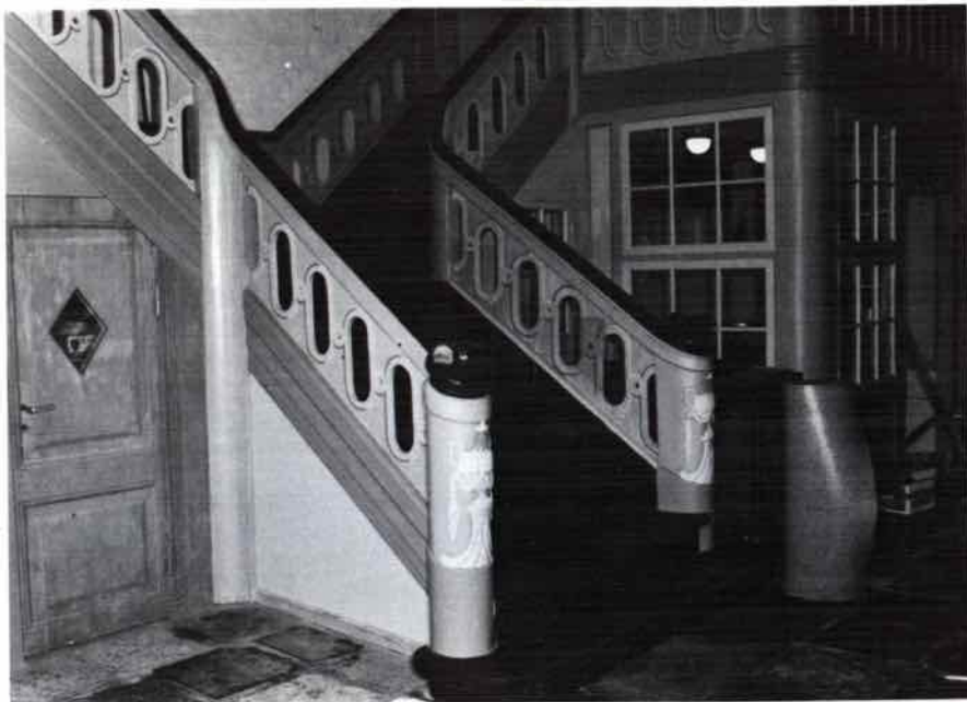
Abb. 27. Königstraße 30. Dielentreppe nach der Restaurierung
