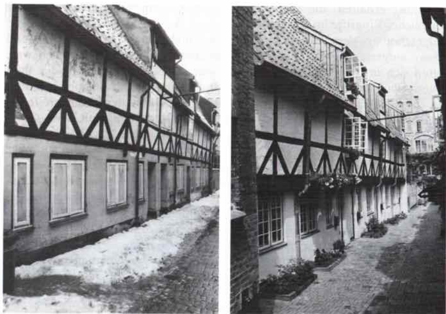
Abb. 19–20. Bäcker gang, Engelsgrube 43, Zustand 1985 und nach der Instandsetzung der Ganghäuser 12–16
