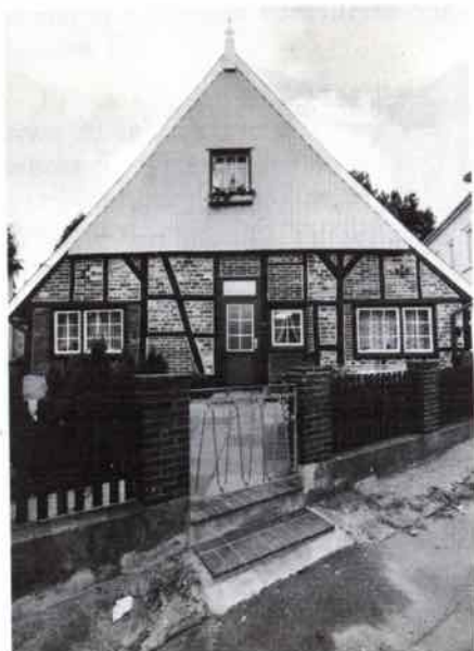
Abb. 37. Schlutup. Bögengang 3 nach der Instandsetzung des Äußeren
