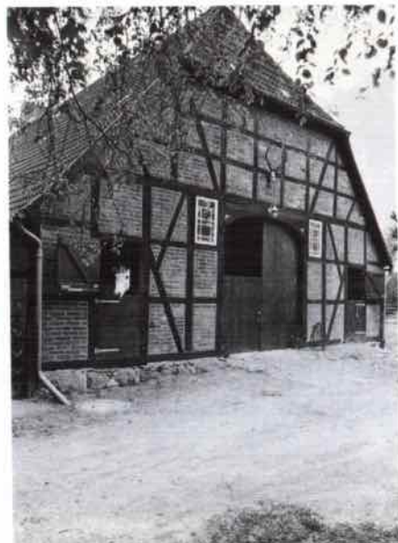
Abb. 38. Wulfsdorf. Ehemaliges Forsthaus mit wiederhergestellter Stallseite
