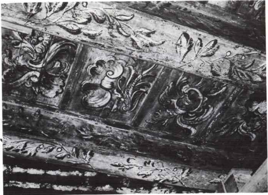
Abb. 16. Große Petersgrube 29. Bemalte Balkendecke im 1. Obergeschoß
