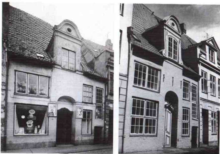
Abb. 30–31. Engelswisch 22. Zustand 1954 und 1986
