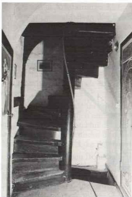
Abb. 9. An der Untertrave 96 – Wendeltreppe zwischen dem 2. und 3. Obergeschoß
