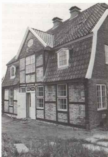
Abb. 35. Ehem. Sommerhaus Steinrader Weg 45 nach der Wiederherstellung
