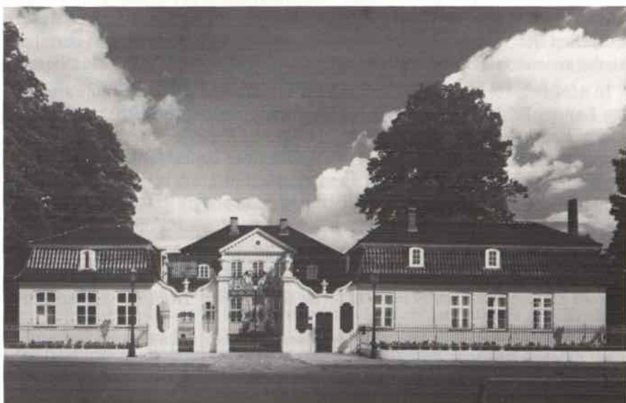
Abb. 37. Ehem. Küsselsches Palais, Einsiedelstraße 10, nach der Wiederherstellung
