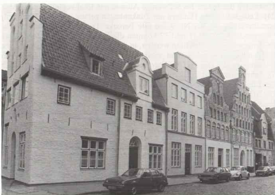
Abb. 24. Tünkenhagen 17/Hundestraße 71–79 nach der Sanierung
