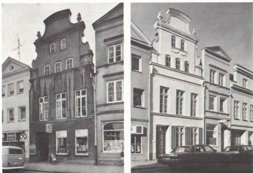
Abb. 31–32. Dr.-Julius-Leber-Straße 58. Zustand 1969 und nach der Wiederherstellung 1985
