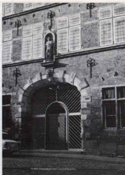
Abb. 13. Zeughaus. Neue Türgestaltung des Nordportals.
