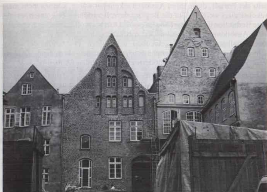
Abb. 14. Große Petersgrube 23–27. Rückfronten nach der Wiederherstellung.
