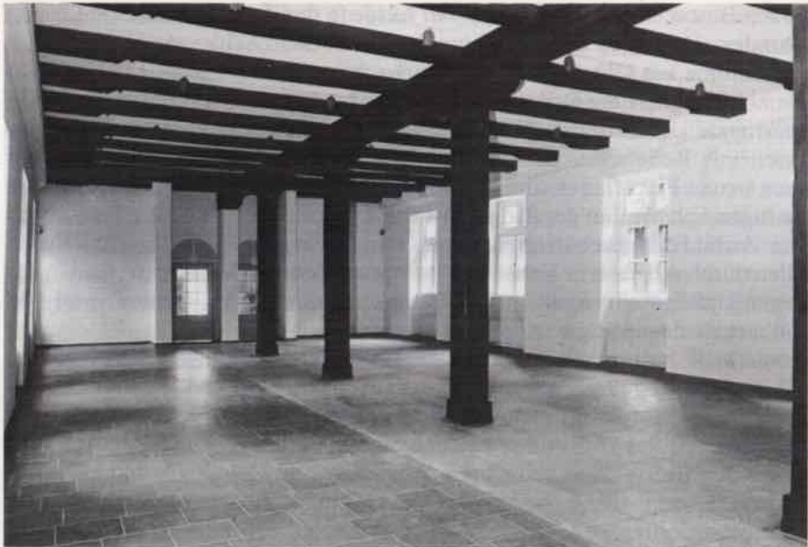
Abb. 11. Zeughaus. Rest des alten Hallenerdgeschosses im nördlichen Teil.
