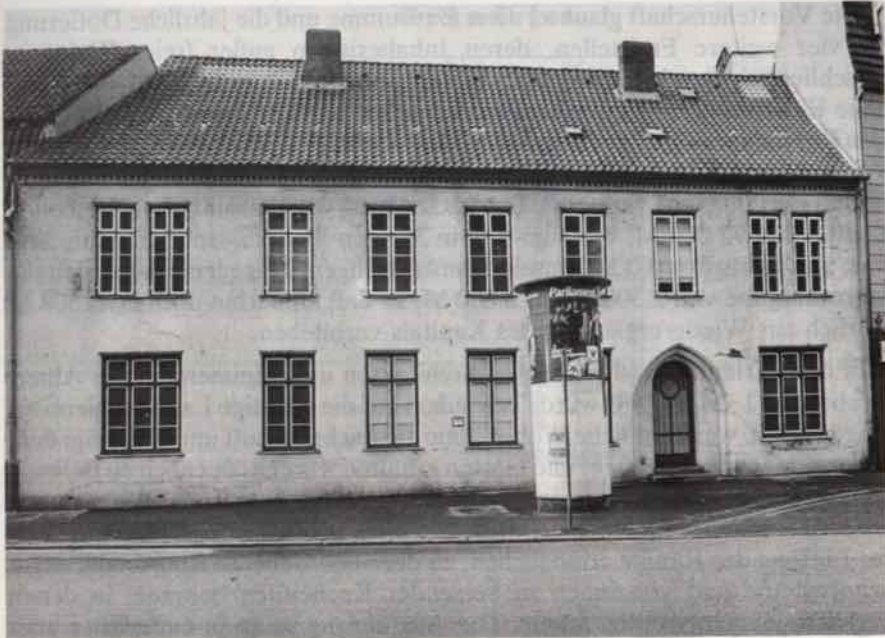
Abb. 2. Zerrentiens Armenhaus, Krähenstraße Nr. 20. Zustand nach dem 1866 erfolgten Umbau.
