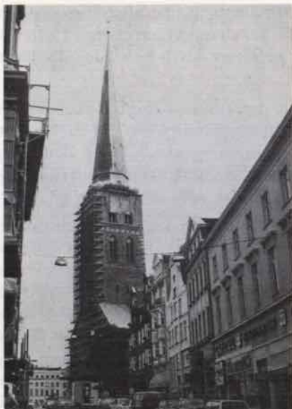
Abb. 3. Jakobikirche. Eingerüstete Westfront von der Breiten Straße aus.
