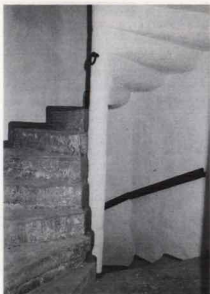
Abb. 12. Zeughaus. Wendeltreppe in dem vor der südlichen Giebelwand liegenden Treppenturm.
