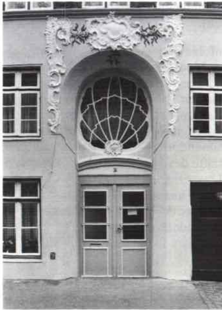
Abb. 27. Große Altfähre 33. Portal nach der Instandsetzung.
