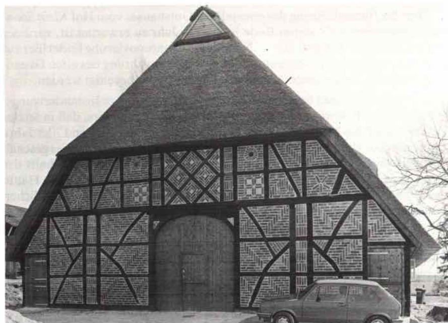
Abb. 31 - 32. Lübeck-Brodten. Hufnerhaus von 1776 vor und nach der Instandsetzung.
