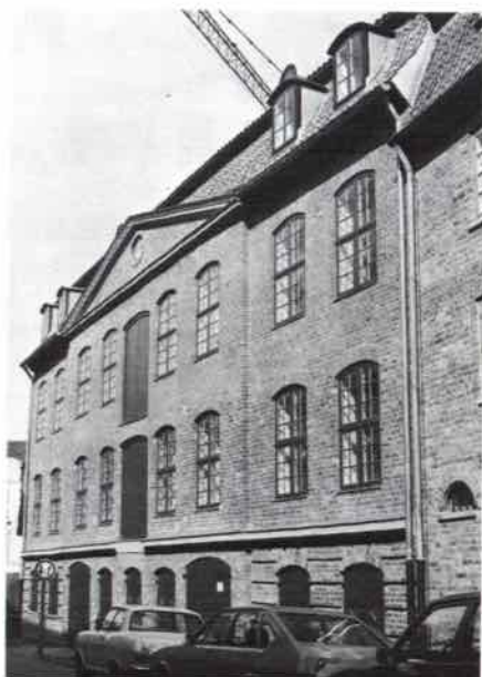
Abb. 16. Depenau 18. Speicher nach dem Umbau für die Musikhochschule.
