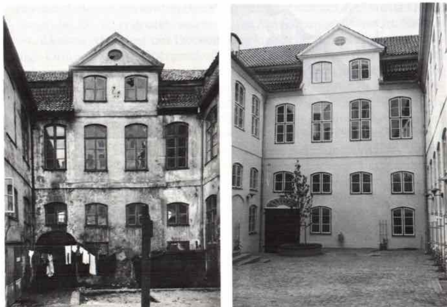
Abb. 14 - 15. Große Petersgrube 21. Innenhof vor und nach der Wiederherstellung.
