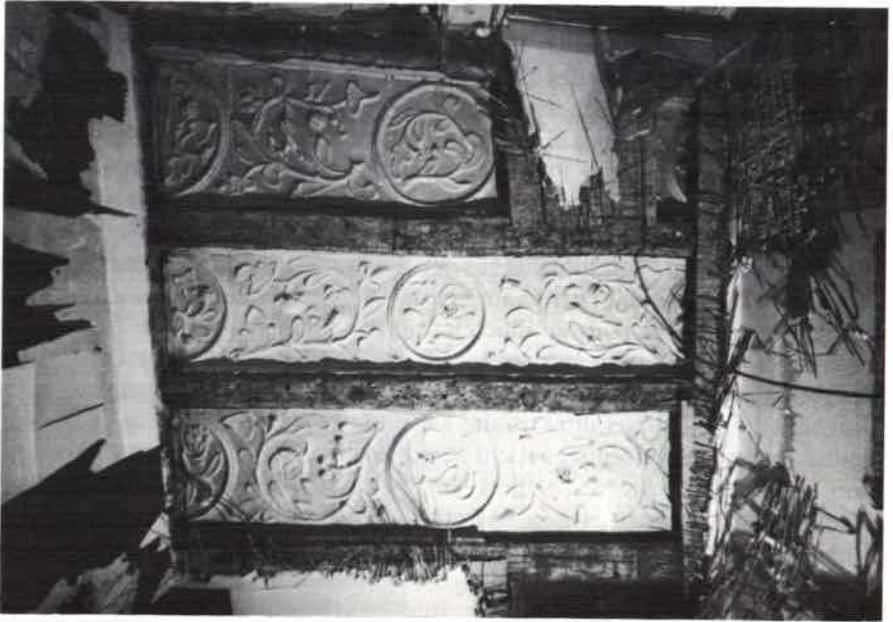
Abb. 17. Koberg 2. Freilegung einer Stuckdecke im 2. Obergeschoß.
