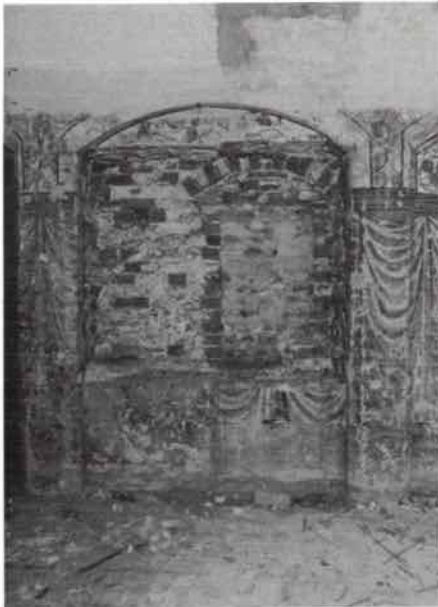
Abb. 4: Katharineum. Ausmalung im oberen Kreuzgang des ehemaligen östlichen Klosterflügels. Im rechten Teil der Nische vermauerter alter Zugang.
