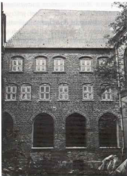
Abb. 5: Burgkloster. Ostseite des sog. Hospitalbaus zum Innenhof. Zustand Juni 1982
