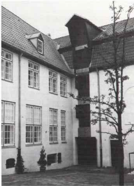
Abb. 14: Große Petersgrube 17-19. Hof mit Rückseite des Speichers Depenau 14-16
