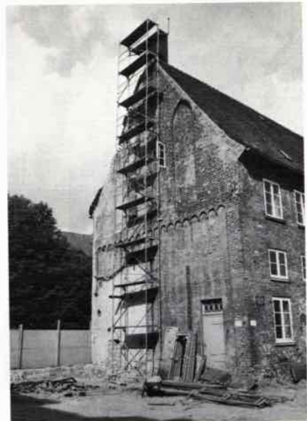
Abb. 8: Refektoriumsbaus des ehemaligen Johannisklosters. Freigelegter Westgiebel.
