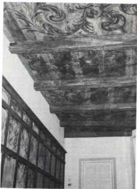
Abb. 18: An der Untertrave 42. Zimmer im Flügelbau mit Balkendecke und Vertäfelung nach der Restaurierung.
