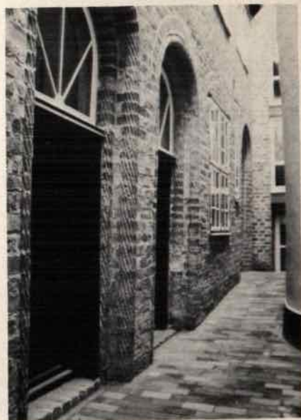
Abb. 13: Kleine Petersgrube 4. St.-Jürgen-Gang nach der Restaurierung.
