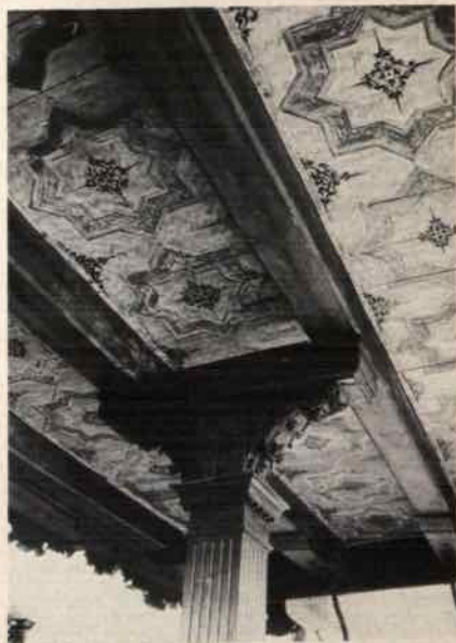
Abb. 7: Aegidienkirche. Unterseite des Singechors nach der Freilegung.
