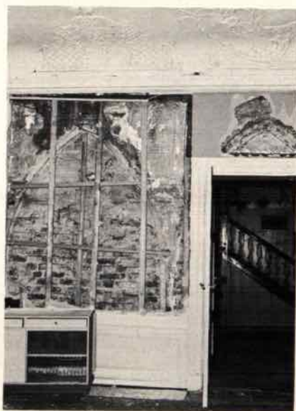
Abb. 20: Koberg 2. Freigelegte östliche Schmalwand des Flügelsaals mit älteren Bogenblenden, möglicherweise die ehemalige Rückfront des Vorderhauses.
