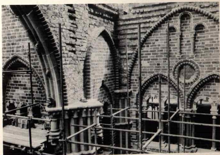
Abb. 2: Dom. Paradies im Wiederaufbau. Inneres mit Hauptgurtbogen. Zustand Juni 1980.
