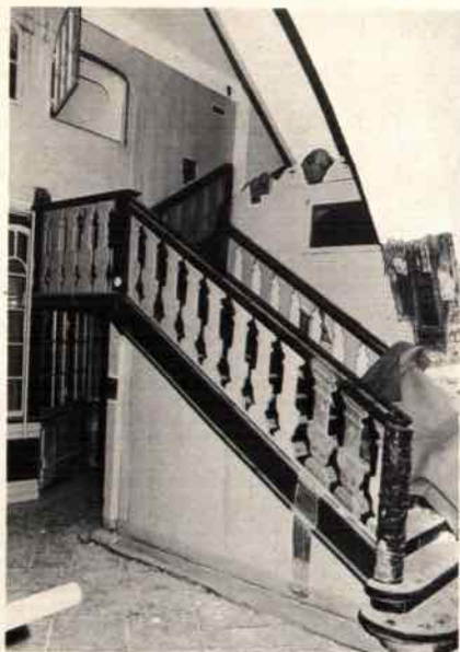
Abb. 19: Koberg 2. Dielentreppe mit Freilegungsproben an der Brüstung und am dahinter gelegenen Verschlag. Rechts alte bemalte Holzkonstruktion unter der später aufgebrauchten Verputzung des breiten Bogens.
