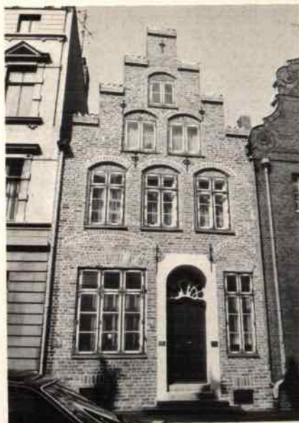
Abb. 6: Königstraße 2 nach Instand- setzung der Fassade.
