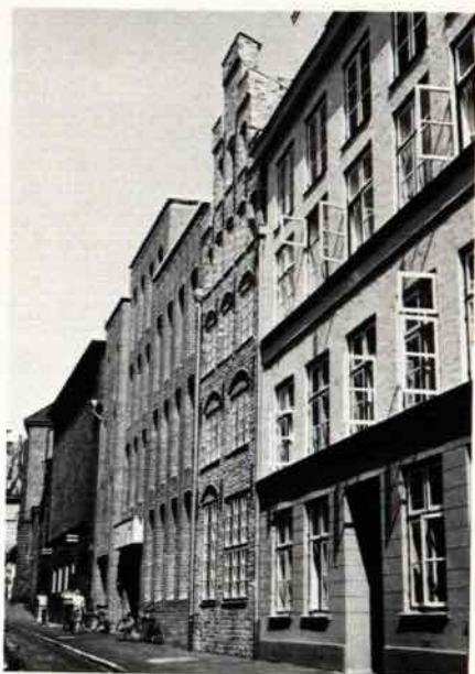
Abb. 10: Obere Hundestraße mit Bibliotheksneubau. Die Fassade von Nr. 15 nach der Rekonstruktion einbezogen.
