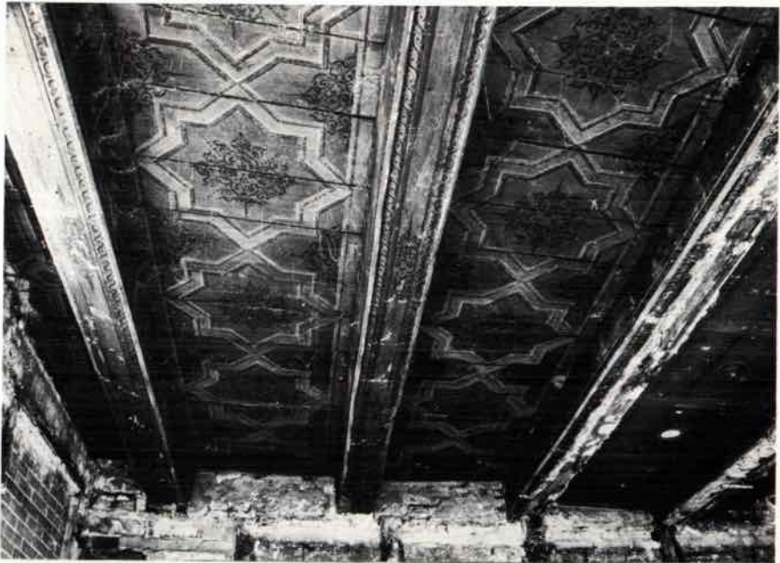
Abb. 7: Jakobikirchhof 4. Freigelegte Balkendecke aus der Entstehungszeit im Erdgeschoß.
