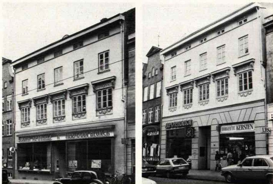
Abb. 15a u. 'b': Mühlenstraße 16 vor und nach der Wiederherstellung der Fassade.
