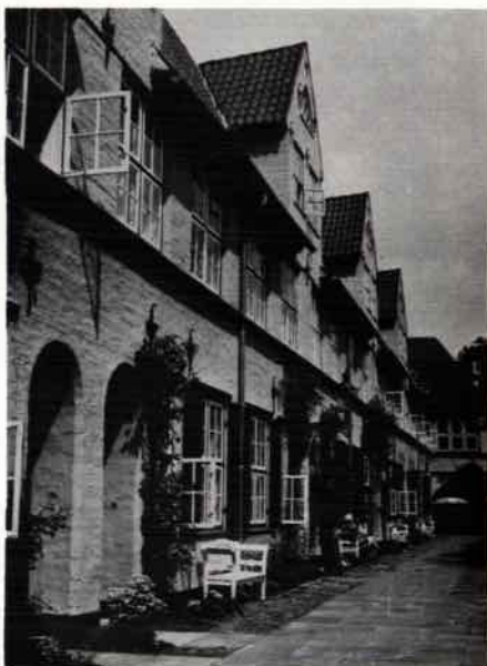
Abb. 9: Füchtings Hof nach dem Umbau.
