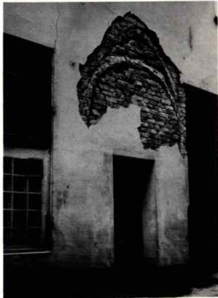
Abb. 14: Engelsgrube 56. Aufgedecktes Portal an der Traufseite.
