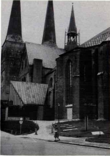
Abb. 1: Dom. Südseite des Chores mit neuem Eingangsvorbau.
