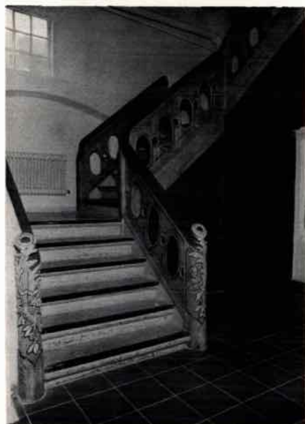
Abb. 19: Travemünde. Treppe in der ehemaligen Vogtei nach der Freilegung.
