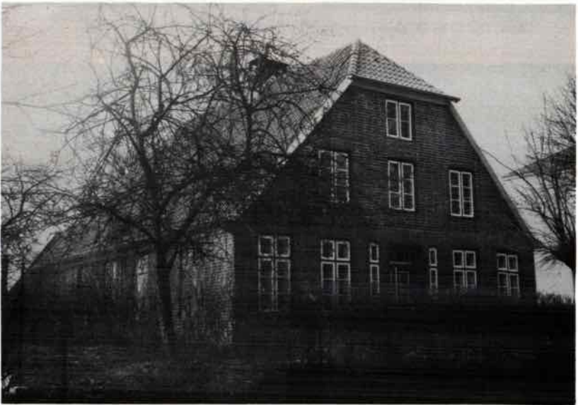
Abb. 21a u. b: Steinrader Weg 51. Ehemaliges Gärtnerhaus vor und nach der Instandsetzung.
