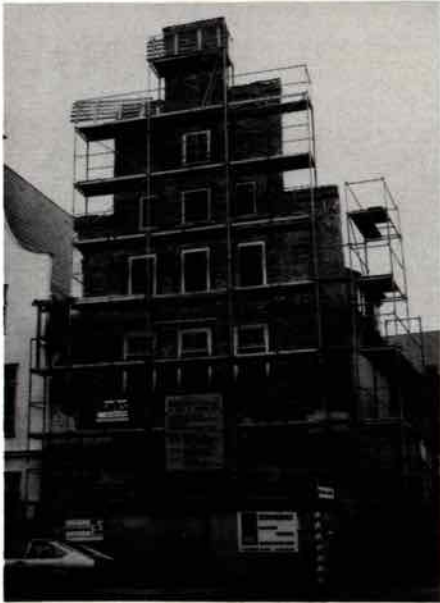
Abb. 13: Engelsgrube 56. Giebelfront nach der Beseitigung des Putzes.
