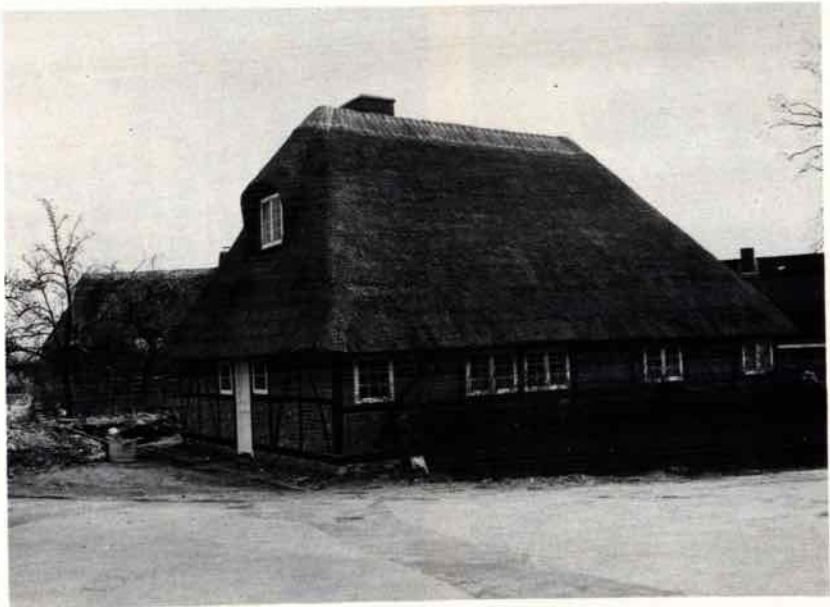
Abb. 19: Dummersdorf, Hudestraße 84 nach dem Durchbau.
