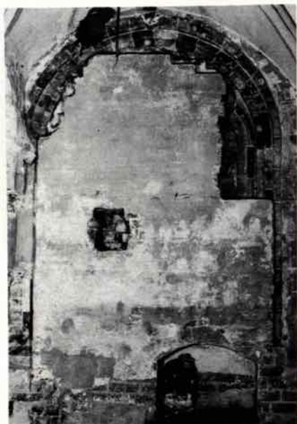
Abb. 9: Burgkloster. Freigelegtes frühgotisches Fenster mit Bemalung.
