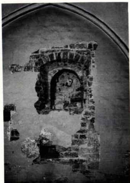
Abb. 8: Burgkloster. Freigelegtes ehem. Außenfenster des Nordflügels.
