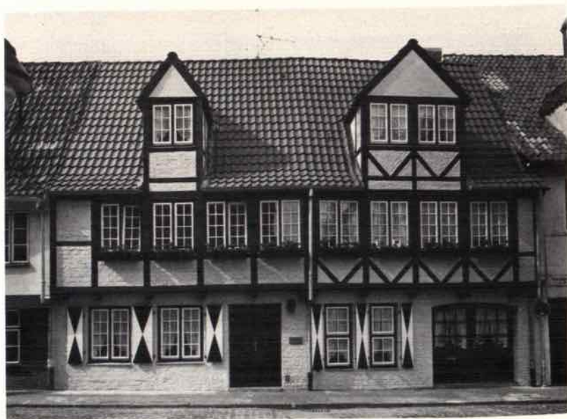
Abb. 10: Große Gröpelgrube 33 -35 nach der Instandsetzung.
