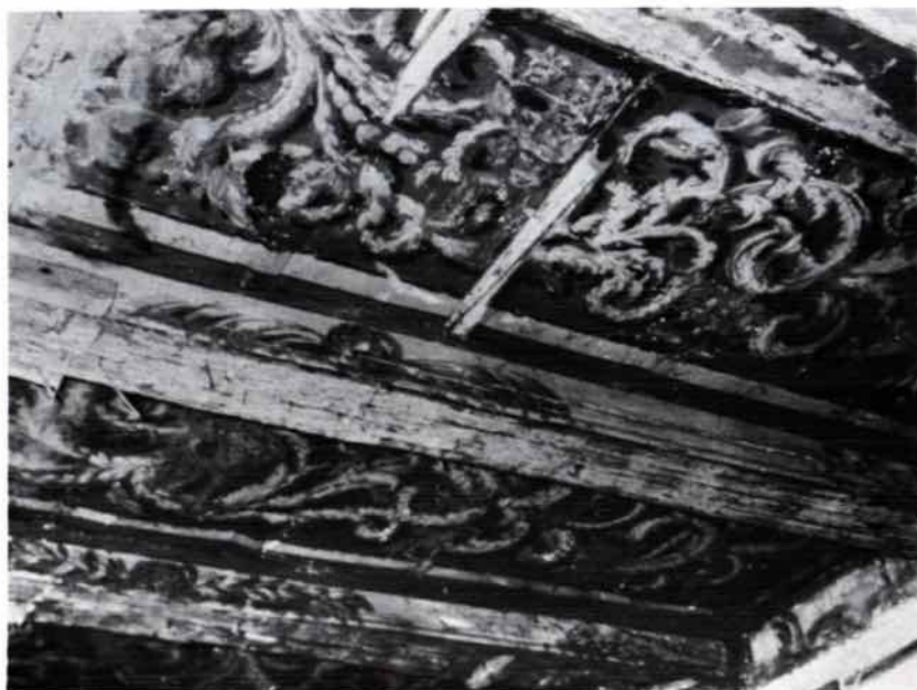
Abb. 9: Mengstraße 43. Freigelegte Balkendecke im Erdgeschoß.
