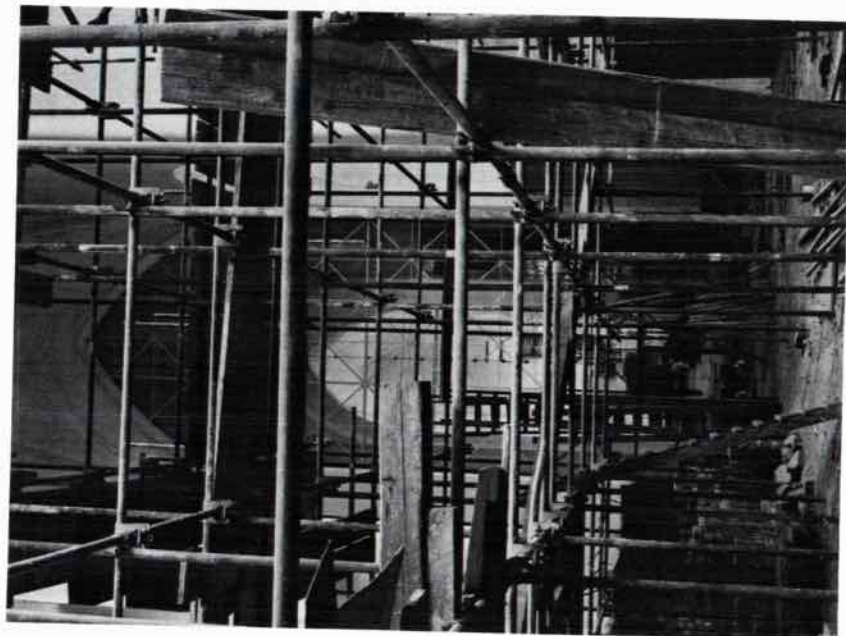
Abb. 1: Dom. Eingerüsteter nördlicher Chorumgang während der Einwölbung.
