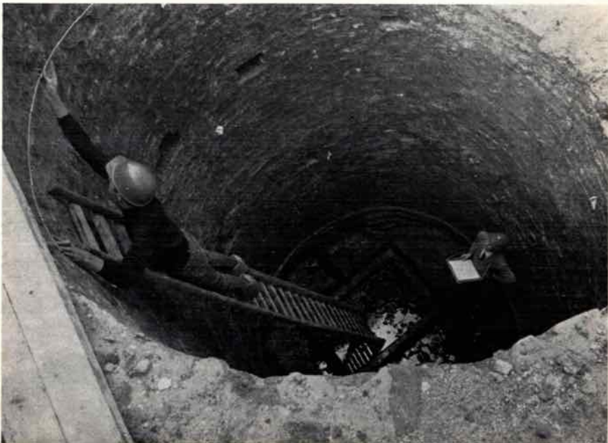
b: Lübeck, Fischstraße 1-3: Blick in den Abraumschacht (S. 107/109).
