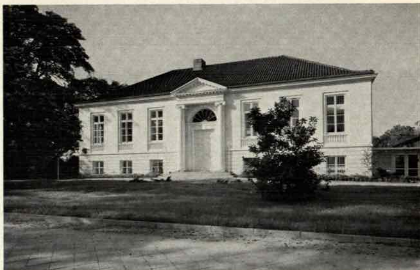
Abb. 5. Linde-Haus, Ratzeburger Allee 16. Straßenseite nach dem Umbau.
