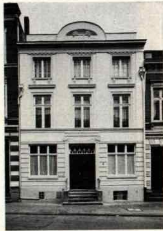
Abb. 9. Haus Pferdemarkt 7 nach Renovierung.
