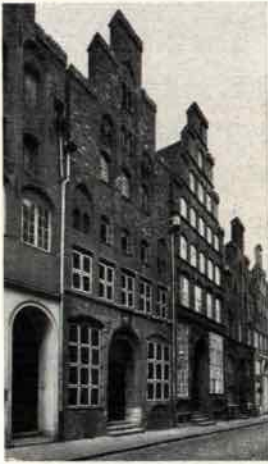
Abb. 8. Haus Mengstraße 25 nach dem Umbau.
