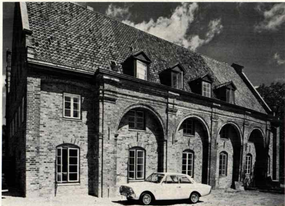
Abb. 5a u. b. Salzspeicher VI. Südfront vor und nach der Instandsetzung. Fotos: Wilh. Castelli
