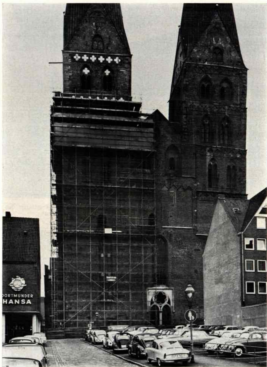
Abb. 3. St. Marien, Westfassade. Eingerüsteter Norderturm mit bereits instand gesetztem oberen Geschoß.
