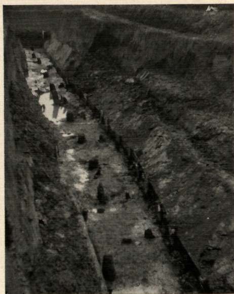
Abb. 4. Stammreihe der Uferbefestigung in Graben H.
