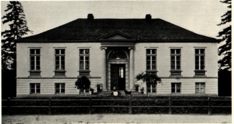
Bild 25. Lillie: Lübeck, Lindesche Villa, Straßenseite, alter Zustand
