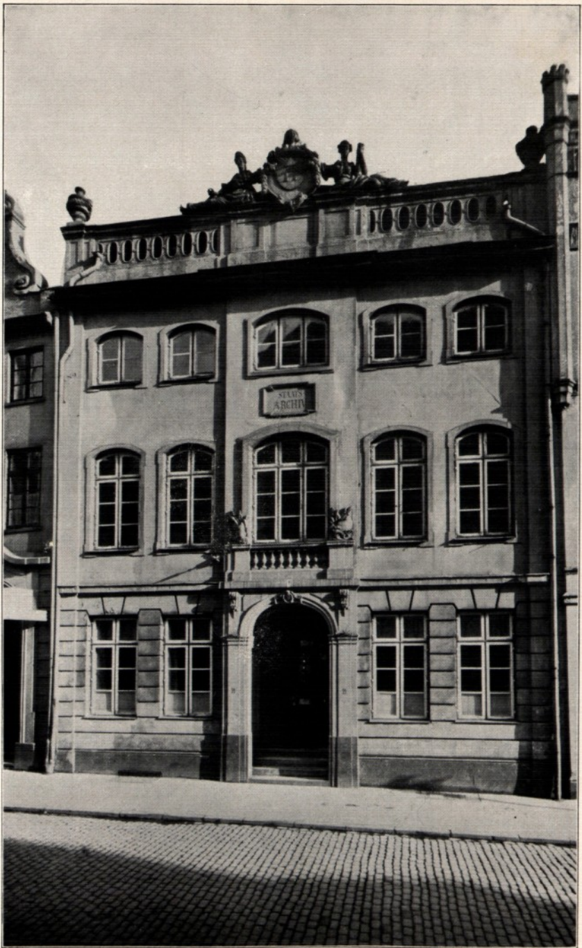
Abb. 4. Fassade des Hauses Königstraße 21, Lübeck.
