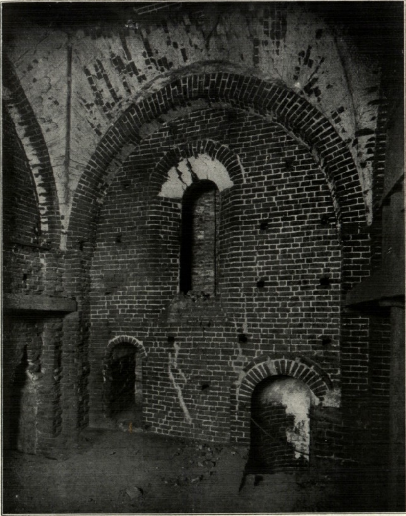
Taf. 9. Überwölbter Raum (Kapelle?) im Süderturm des Lübecker Doms. Bemerkenswert Kämpferprofil rechts aus Ziegelsteinen, die Hausteinformen nachahmen.
