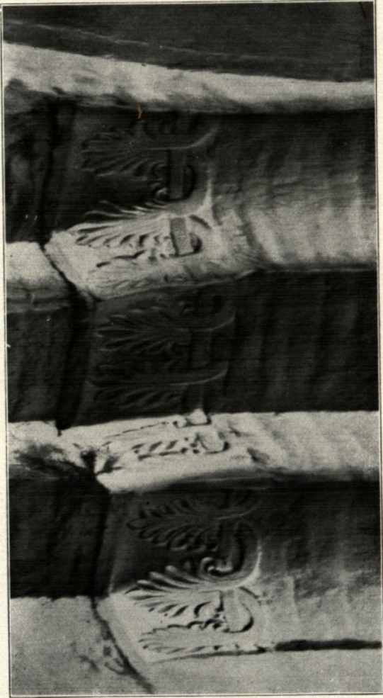
a) Kämpfersteine im Chor des Lübecker Doms aus Gipsbeton. (Bemalt.)
