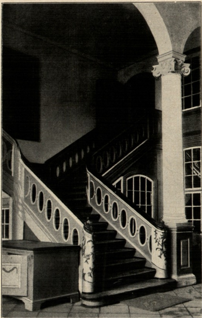
Abb. 83. Lübeck. Schabbel-Haus, Haupttreppe der Diele (vgl. Abb. 32 und 33).
