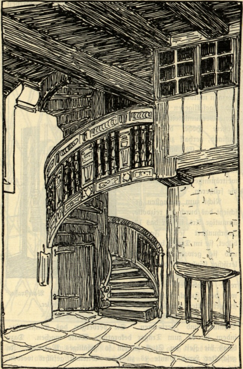
Abb. 65. Lüneburg. Bardowiderstraße (vgl. Abb. 18).
