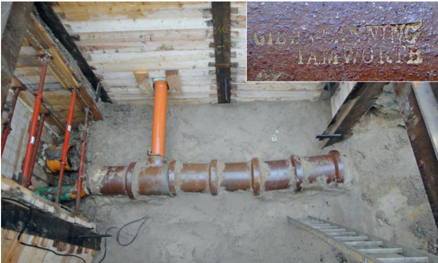
Abb. 31: Alfstraße. Ab 1856 begann man mit dem Bau von Entwässerungskanälen aus runden glasierten Tonrohren, die u. a. aus England importiert wurden: In der Alfstraße wurden 3,50 m unter Niveau Röhren der Fa. Gibbs & Canning verlegt.
