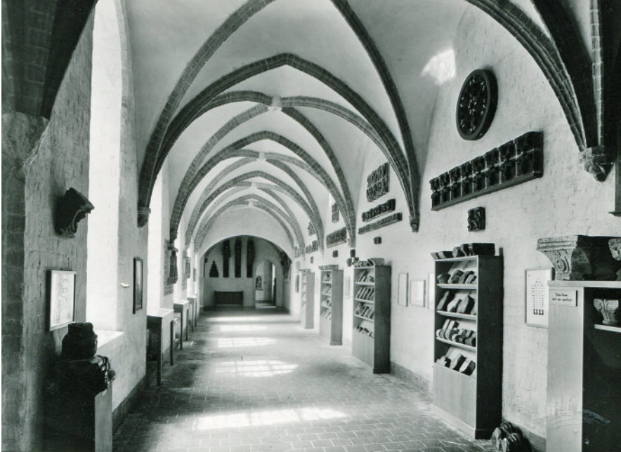
Abb. 2: St. Annen-Museum, westlicher Kreuzgang mit Bauspolien, um 1937.
