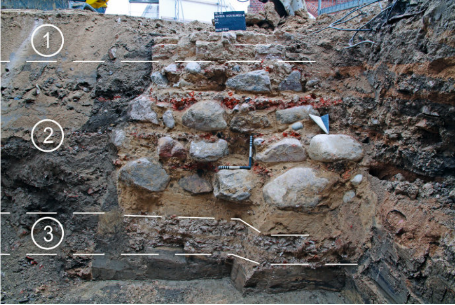
Abb. 3: Grabung „Europäisches Hansemuseum“. Schnitt durch die Westmauer der 1441 fertig gestellten und 1818 wegen Baufälligkeit abgerissenen Klosterkirche.
