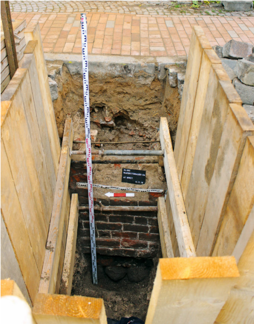
Abb. 24: Wakenitzmauer 3a. Die Stadtmauer des frühen 13. Jh.s liegt in dieser Straße nicht unter den Hausfassaden sondern unterhalb der Bodensteinkante.
