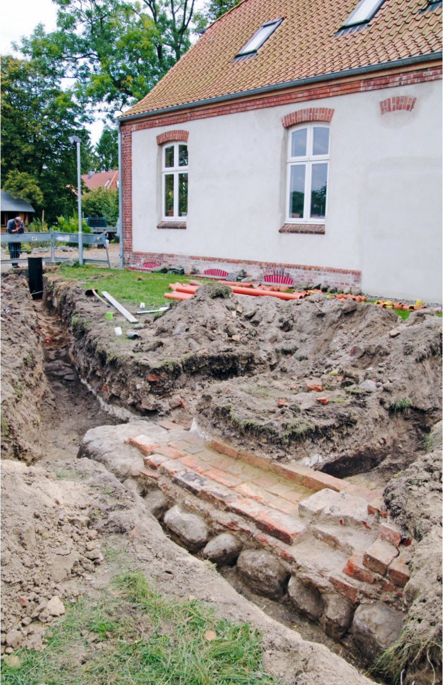
Abb. 29: Stadtgut Roggenhorst. Backsteinmauer auf Findlingsgründung, Neuzeit (Reste eines Vorgängerbaus).
