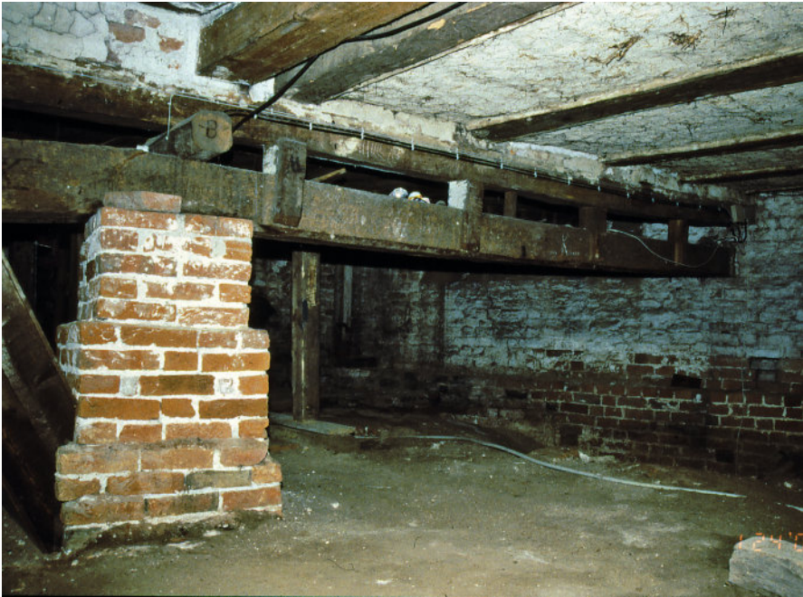
Abb. 7: Korrektur des Fußbodenniveaus durch Aufmauerung des Pfeilers.
