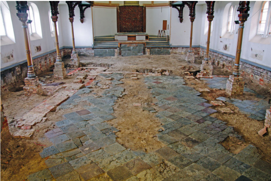
Abb. 11: St.-Annen-Straße 13 (Synagoge). Reste des ebenerdigen mittelalterlichen Gebäudeteils (Fußboden mit Gotland- und Öland-Platten sowie Mauerwerksreste. – Die Höhe des vor der Sanierung vorhandenen Fußbodenniveaus der Synagoge ist an den Umfassungsmauern sowie den aufgeständerten Stützen ablesbar.
