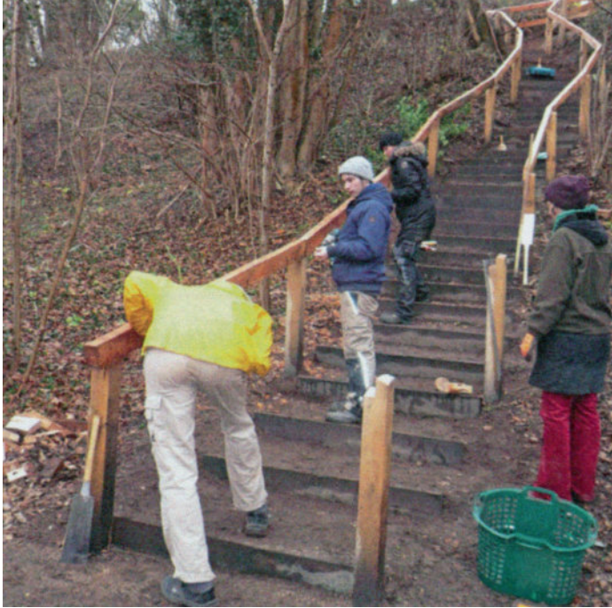
Abb. 28: Das mobile Einsatzteam der „Jugendbauhütte Lübeck“ bei der Reparatur der Treppe zum „Pöppendorfer Ringwall“.
