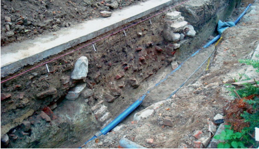
Abb. 25: Gut Mori (Groß Steinrade). Fundamente (Findlinge) und eingetiefter Teil (Backsteinmauern) eines Gebäudetraktes aus der 1. Hälfte des 17. Jh.s.
