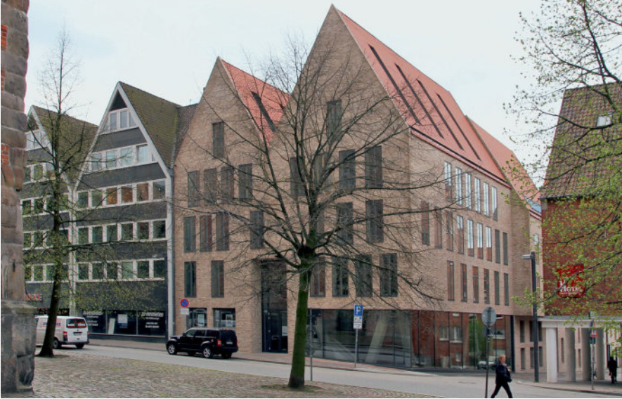
Abb. 14: Schlüsselbuden 6-8 (Ulrich-Gabler-Haus). Die großen Glasflächen entlang von Alfstraße und Schlüsselbuden ermöglichen den freien Blick auf den historischen Keller (frühes 13. Jh.).
