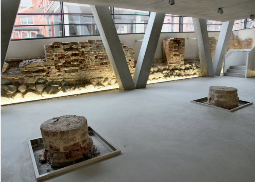
Abb. 13: Schüsselbuden 6-8 (Ulrich-Gabler-Haus). (Gewölbe-) Keller des „Saalgeschosshauses“ Schüsselbuden 6 kurz vor der offiziellen Einweihung des Neubaus. Zukünftig soll auf dieser Ebene ein Café betrieben werden.
