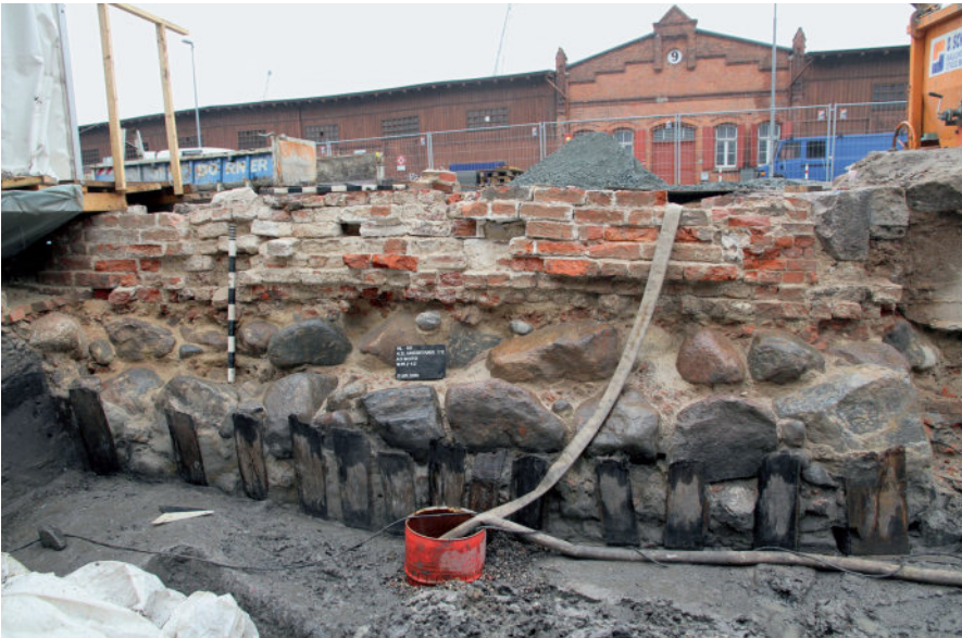
Abb. 21: An der Untertrave (Gr. Altefähre – Hubbrücke). Blick auf eine der Längsmauern des „Arsenals“ (Innenansicht); die Baugrube des mehrlagigen Findlings-Fundamentes wurde wegen des weichen Untergrundes mit senkrechten Eichenbohlen ausgesteift.
