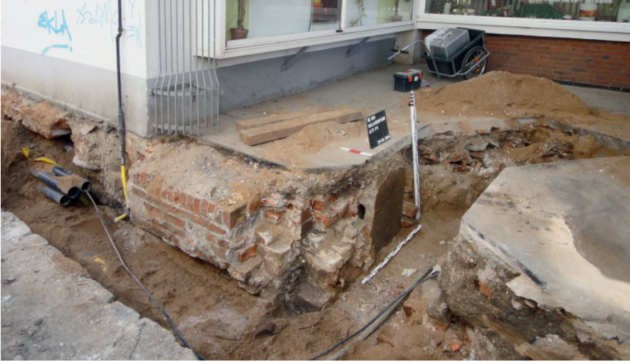
Abb. 24: Balauerfohr (Hüxstraße – Wahnstraße). Durch die Leitungsverlegungen wieder sichtbar gewordene historische Bauflucht (Haus Nr. 9).
