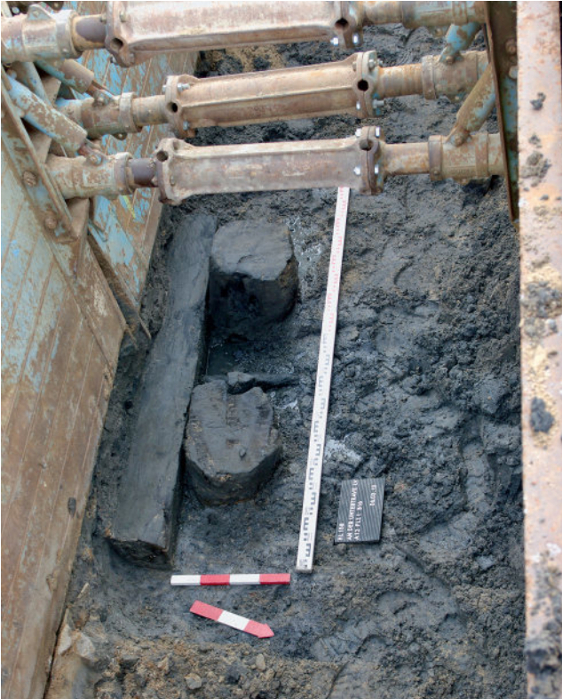
Abb. 18: An der Untertrave (Gr. Altfähre – Hubbrücke). „Landseitiges“ Ende der hölzernen Zuganker-Konstruktion für die Kaimauer des 19. Jahrhunderts.
