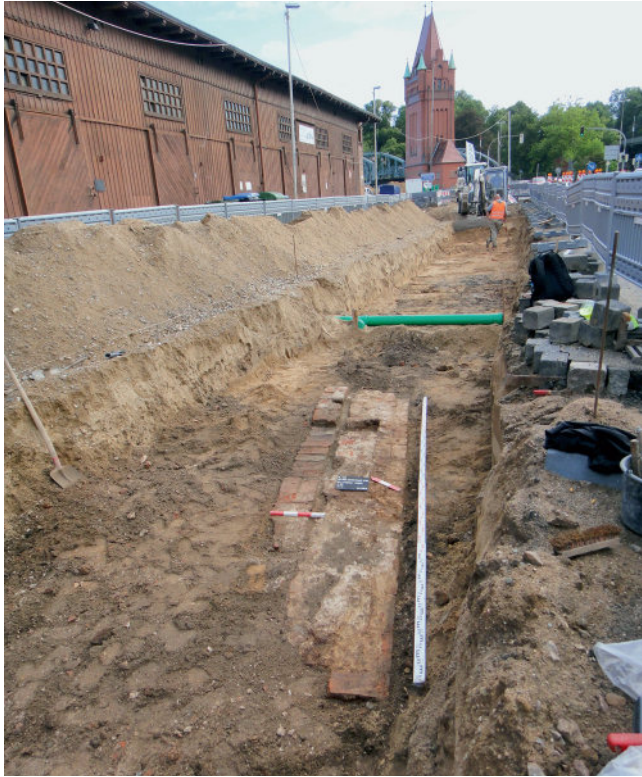
Abb. 16: An der Untertrave (Gr. Altefähre – Hubbrücke). Stadtmauer des 13. Jh.s, aufgedeckt vor „Schuppen 9“. Nördlich davon wurde im gleichen Baugraben der mittelalterliche Hexenturm freigelegt.
