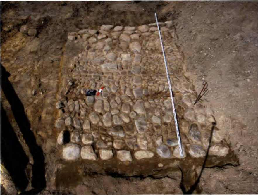
Abb. 27: Neubau „K 13“ (Kreisstraße 13) / Steinrader Hauptstraße: Historisches Straßenpflaster (Neuzeit), über hölzernen Unterzügen verlegt, die aber auch zu einer älteren „Holzstraße“ gehört haben könnten.
