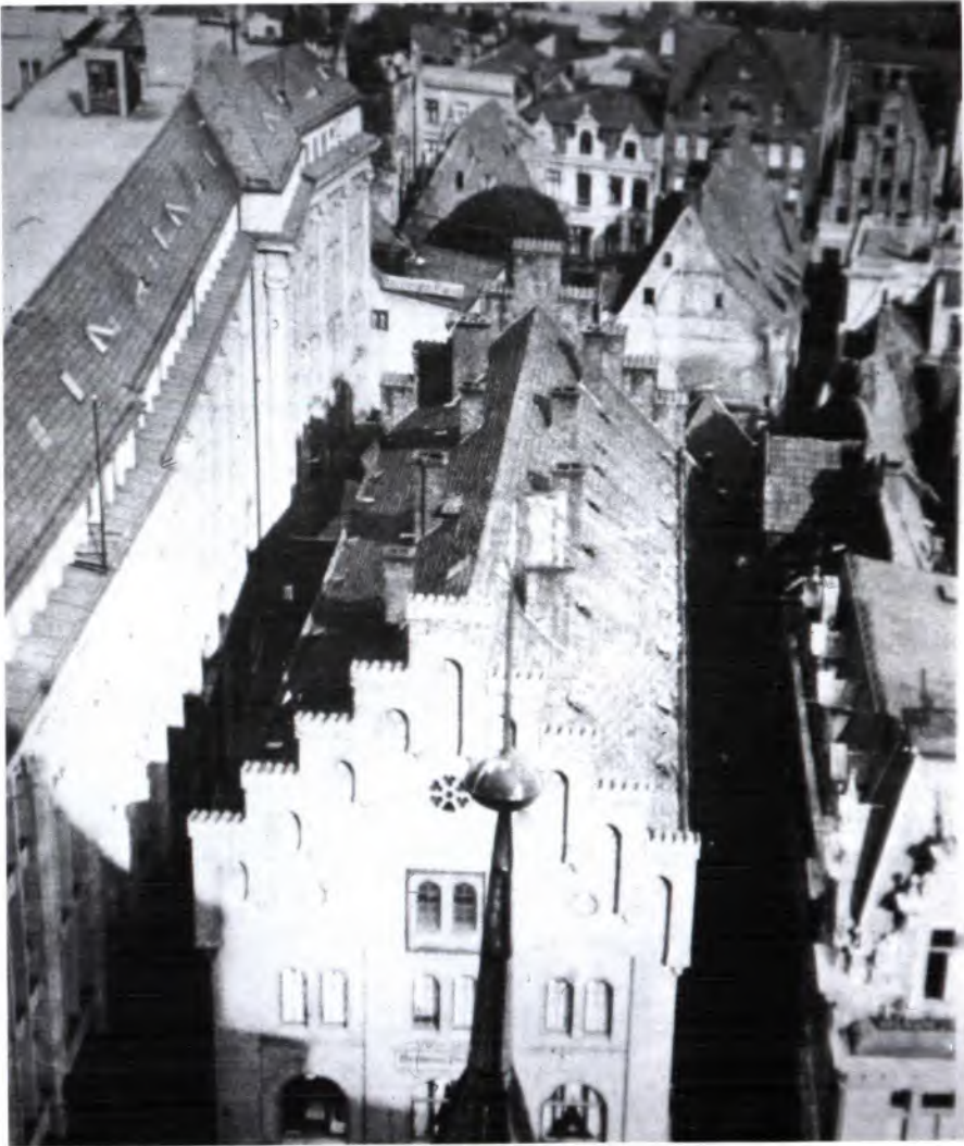
Abb. 13: Projekt „Mitten in Lübeck“. Oberer Schranken. Das Spritzenhaus von 1855 (von W).
