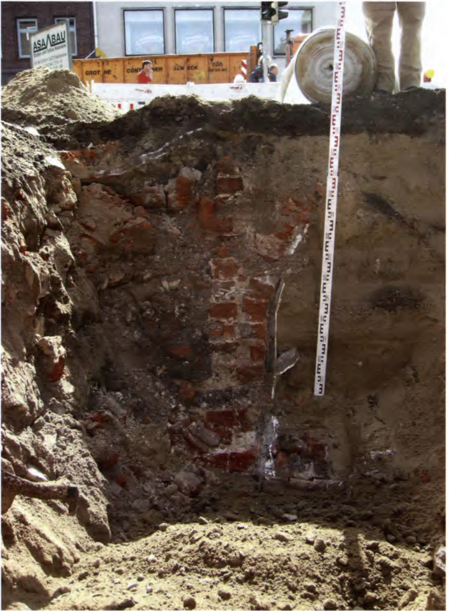
Abb. 10: Projekt „Mitten in Lübeck“. Kohlmarkt 4: Unter der Straße freigelegtes mittelalterliches Keller-Mauerwerk mit Gewölbeansatz.
