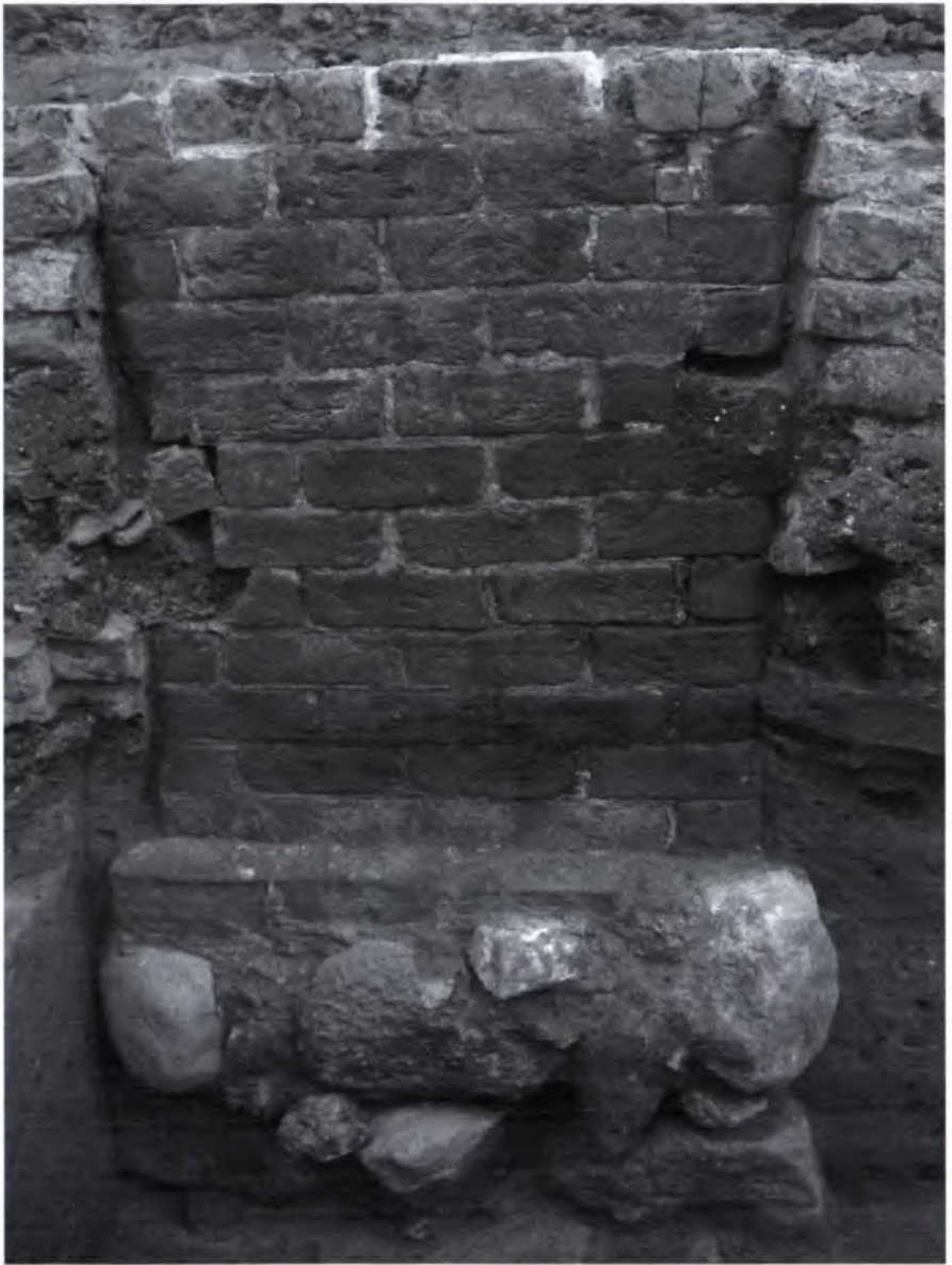
Abb. 18: Breite Straße 93. Südansicht des Mittelpfeilers für das hier zu rekonstruierende Kreuzgratgewölbe aus der Zeit um 1200; das Mauerwerk daneben ist wesentlich jüngerer Zeitstellung.
