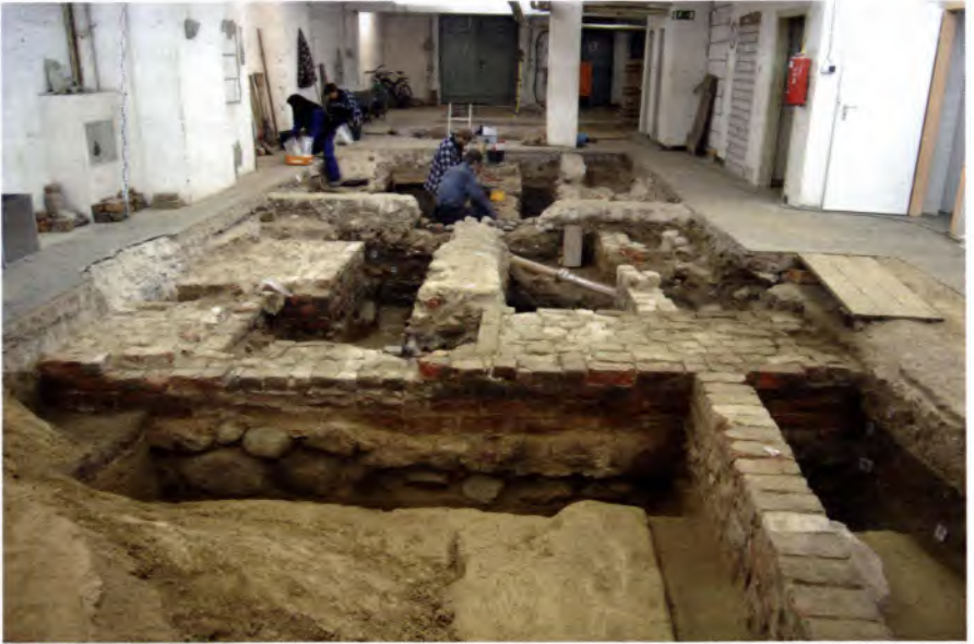
Abb. 20: Breite Straße 93. Blick in die Ausgrabung (von W). Vorne: Die 1,20 m starke hangseitige Gebäudemauer, mittig „Störung“ durch späteren Treppeneinbau? Links: Fundament für einen Ofen im EG?
