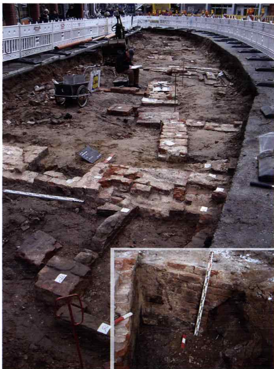
Abb. 25: Projekt „Mitten in Lübeck“. Unmittelbar unter dem Pflaster waren in der Sandstraße sowohl mittelalterliche Brandmauern, neuzeitliche Kellerschächte als auch Überreste historischer Fassaden aus verschiedenen Epochen im Boden erhalten (s. S. 354).
