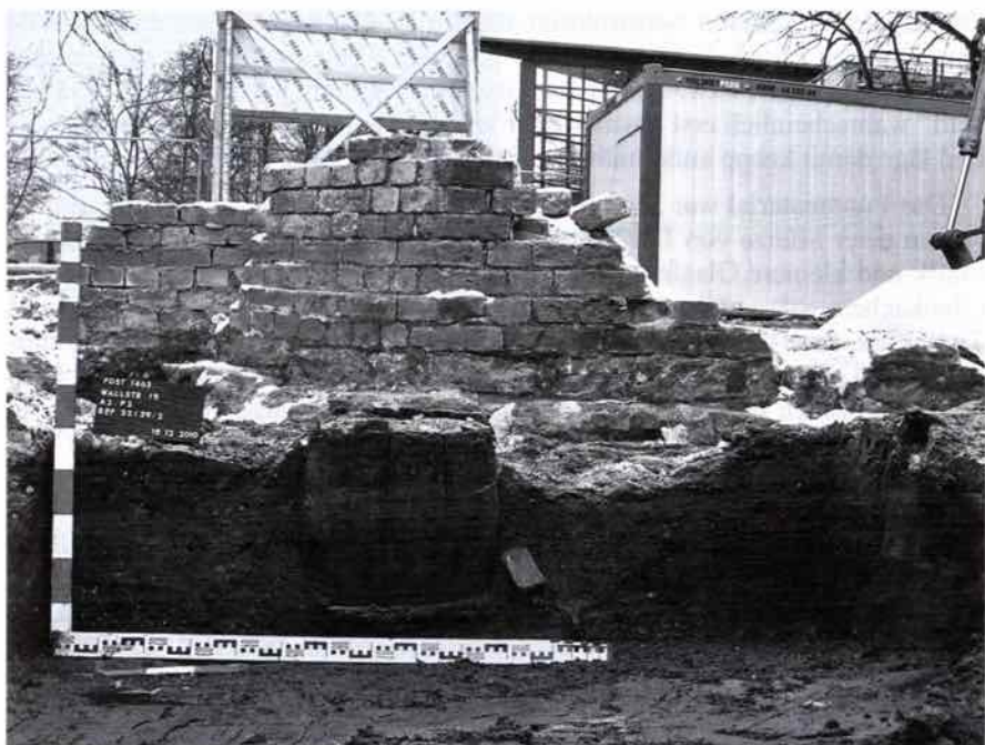
Abb. 13: Wallstraße 15. Drainagefass innerhalb des klassizistischen Wohngebäudes aus dem 19. Jahrhundert.
