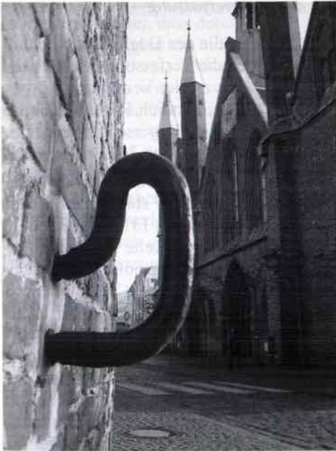
Abb. 1: Durch solche Krampen wurden Straßensperrketten bei Kriegsgefahr oder Unruhen im Inneren gezogen, um Straßen (hier Ecke Königstraße/Koberg) für Pferde und Wagen zu sperren.
