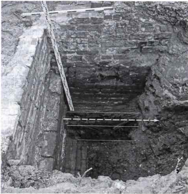
Abb. 22: Ellerbrook. Durch Haus 21 verlegte hölzerne Wasserleitung (links: Straßenseite, hinten: Brandmauer zum Ge- bäude Nr. 19).
