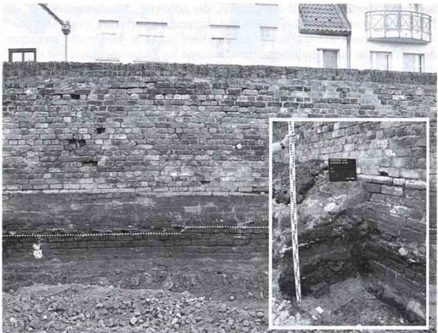
Abb. 17: Kanalstraße 42-50, Blick auf die „Stadtmauer“ von Osten. Der mittelalterliche Bestand aus dem 1. Drittel des 13. Jahrhunderts ist bis auf den Bereich unterhalb der Markierung reduziert worden. Detail: Unterkante der Mauer auf Findlingsgründung, danach mit isolierendem Lehmpaket versehen (links).
