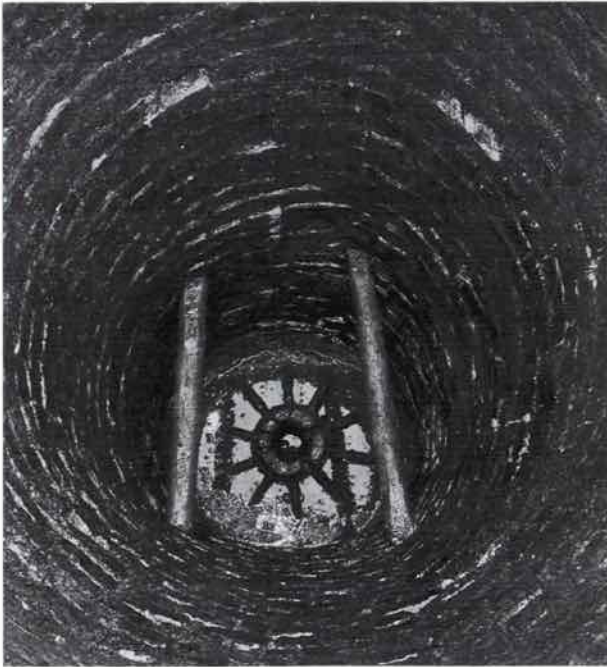
Abb. 6: Grabung „Beckergrube/ Ellerbrook“. Blick in eine geleerte Kloake im Hof des Grundstücks Be- ckergrube 52; zuunterst ein Wagenrad, das beim Bau des Backsteinringes als Maß für den Durch- messer diente.
