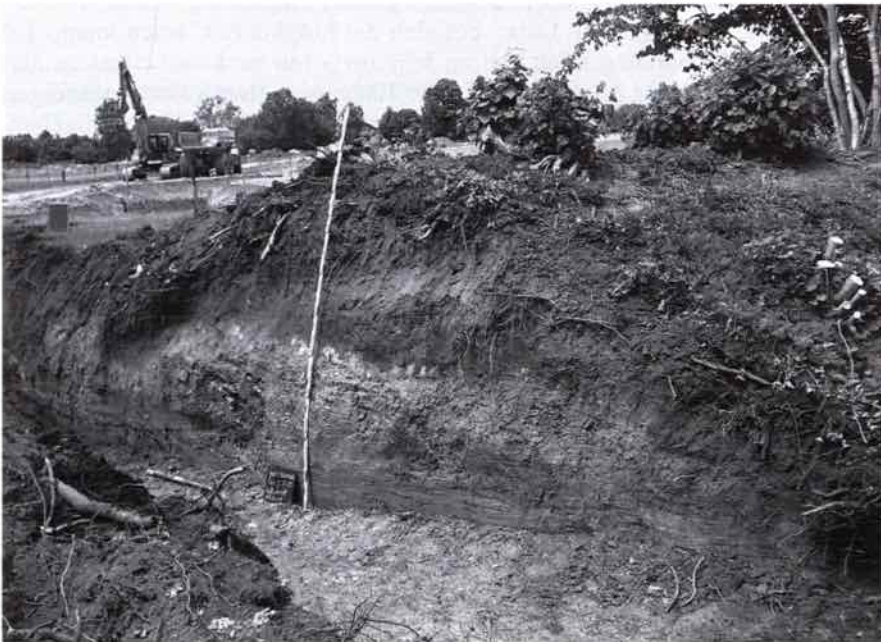
Abb. 23: Groß Steinrade. Schnitt durch den Wall der mittelalterlichen Landwehr in Groß Steinrade.
